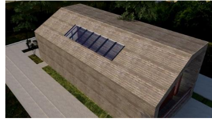
Şekil 7: Çatı ile bütünleşik kullanılan FV panel uygulaması (Çatı-2)
