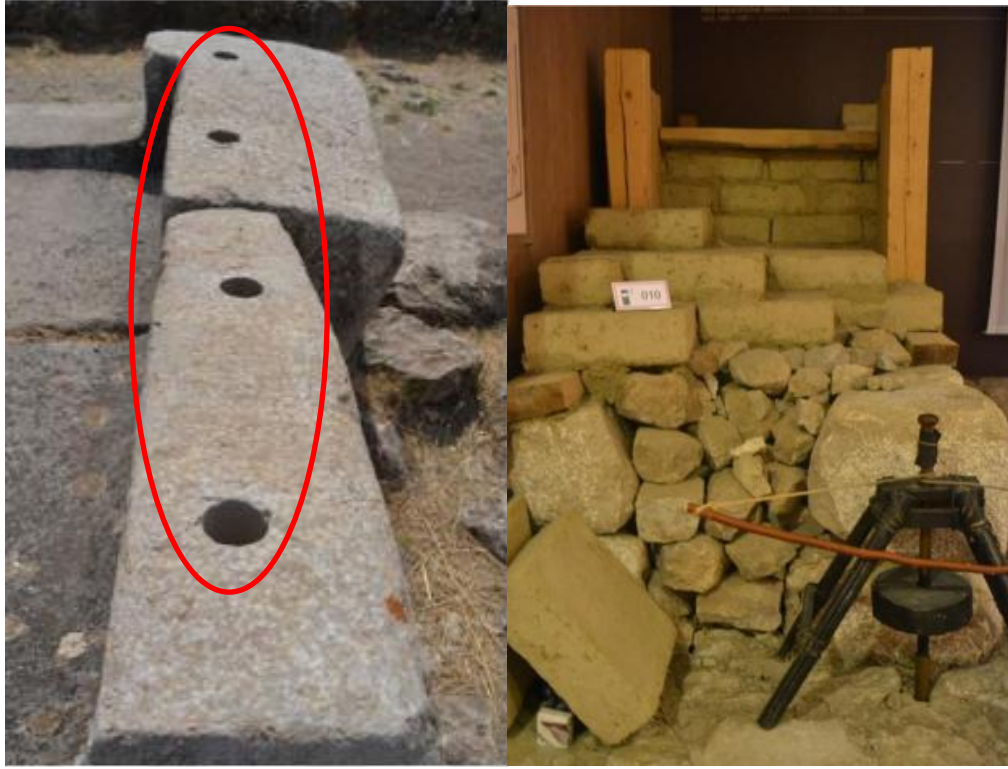
Resim 15. Zıvana Delikleri (Salihoğlu, 2017,s.9) Resim 16. Duvar yapısı ve yapımı Çorum Müzesi'nden (Salihoğlu, 2017,s.79)
