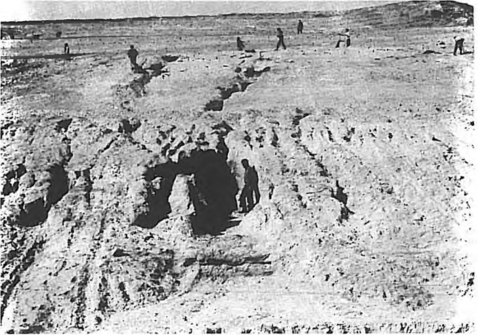
Resim 1 : Şev tahkimi çalışması öncesinde Kartaltepe'deki erozyon. Figure 1 : Erosion at Kartaltepe before the slope stabilization work.
