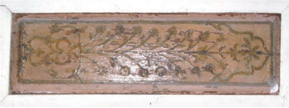
Şekil 16, 17. Ahşap kapı kanatları üzerindeki niteliksiz boyada oluşan tahribatlar
