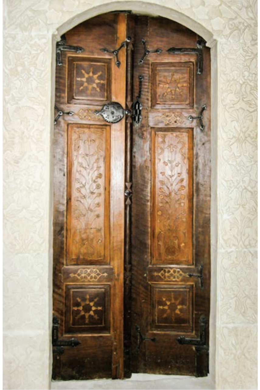
Şekil 30. Minber kapı kanatlarının genel koruma uygulaması sonrası görünüşü
