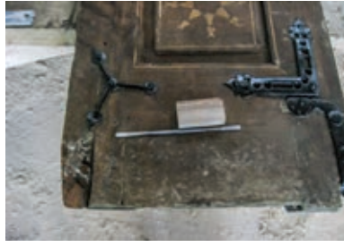
Şekil 13. Boyanarak kapatılmış yatay çift çiçek motifli Şekil 14, 15. Kapı kanatlarının zemine yakın kısımlarında oluşan parça kayıpları
