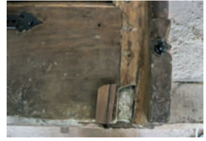
Şekil 13. Boyanarak kapatılmış yatay çift çiçek motifli Şekil 14, 15. Kapı kanatlarının zemine yakın kısımlarında oluşan parça kayıpları
