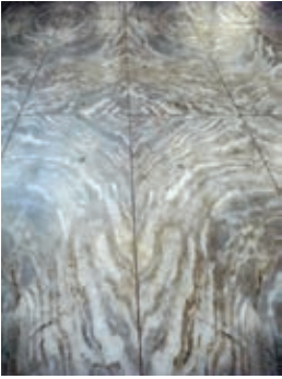
Şekil 7. Ayasofya'nın naos zemininde Marmara mermeri plakalarının trapez biçimli dizilişi.
