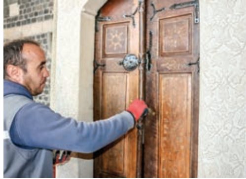
Şekil 28, 29. Yüzey koruyucu uygulaması
