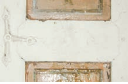
Şekil 13. Boyanarak kapatılmış yatay çift çiçek motifli Şekil 14, 15. Kapı kanatlarının zemine yakın kısımlarında oluşan parça kayıpları
