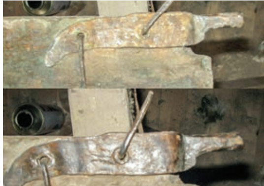
Sekil 22, 23. Metal elemanların dişçi motoru ile temizlenmesi
