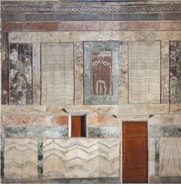
Şekil 12. Kariye Müzesi naos güney duvarı alt kısmında sonradan yerleştirilen Marmara Mermeri kaplamalar (1947-1958 yılları arasında kapı kaldırılarak Bizans Enstitüsü tarafından yapılan tamir). Sağdaki resim 1903-1906 Rus Arkeoloji Enstitüsü arşivinden alınmıştır.
