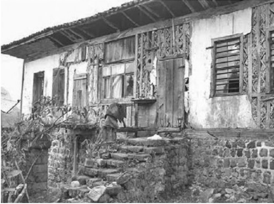
Şekil 18: Çakatura yapım sistemi (Güler ve Bilge 2013)
