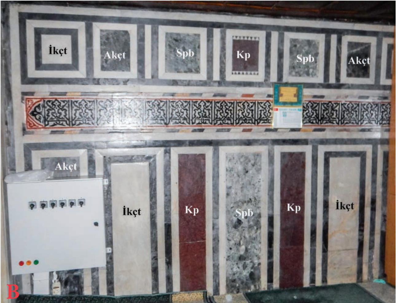
Sekil 27a. K taş kompozisyonu, b. B taş kompozisyonu (B kompozisyonu müezzin mahfili altında yer aldığından üst levhalar kısa tutulmuş ve kare şeklinde yerleştirilmiştir)
