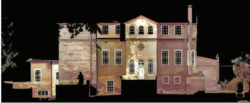
Şekil 15. Güneydoğu cephesi lazer tarama verisi (Renkli nokta bulutu görseli)
