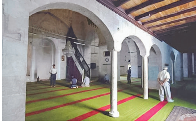
Sekil 20. Üstte onarım öncesi Mardin Ulu Camii mahfil katını taşıyan basık kemerli sütunlar; altta bugün cami avlusunun bir köşesindeki atıl durumları
