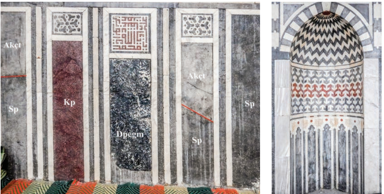
Şekil 17. Cephede sağ dış kompozisyon levhaları. Ortadaki diyorit pegmatit (Dpegm) levhası Mısır kaynaklıdır. Soldan ilk levha tamir görmüştür: Siyah porfir yerine üst kısım Aluç yaylası rudistli kireçtaşı kaplıdır (Akçt); Şekil 18. Dış cephede, son cemaat yeri mihrabiyesi süslemeleri
