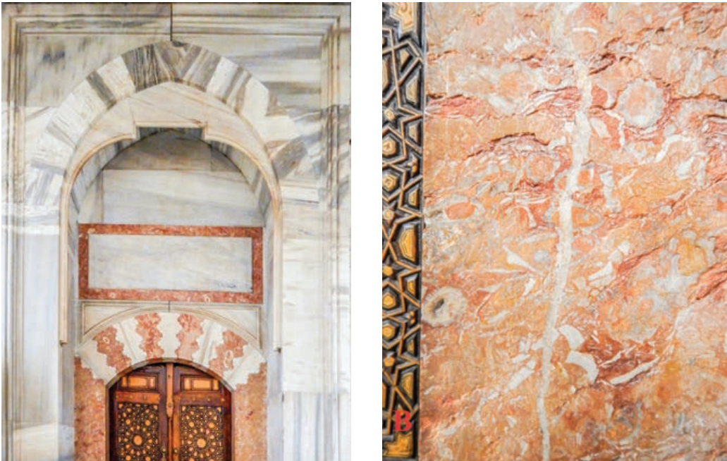
Şekil 36a. Türbe kapısı ayrıntısı b. Kapı sövesi taşı olarak kullanılan rudist fosilli Kutluca kireçtaşı (Kut)
