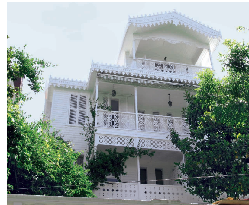
Bakım-onarım izni verilen yapının onarım sonrası görünümü.
