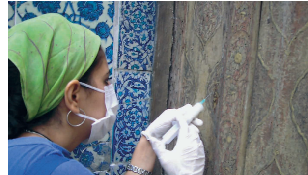
Enjeksiyon yöntemiyle kimyasal koruma (Yeni Cami Hünkâr Kasrı çalışmaları)
