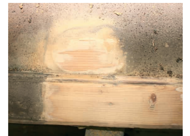
Mekanik yöntem ve ısı yöntemi ile boya sökümü
