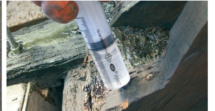
Enjeksiyon yöntemiyle sağlamlaştırma (Yeni Cami Hünkâr Kasrı çalışmaları)
