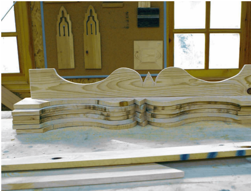
Ahşap elemanların yeniden üretilmesi (sol), çürüyen kısımların yerine parça eklenmesi (sağ)
