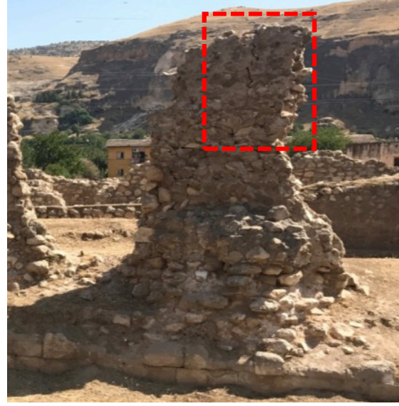
Resim 6. Mardinike Külliyesi Yapı Kalıntılarında Çatlak / Ayrışma Örnekleri (Yazar Arşivi)
