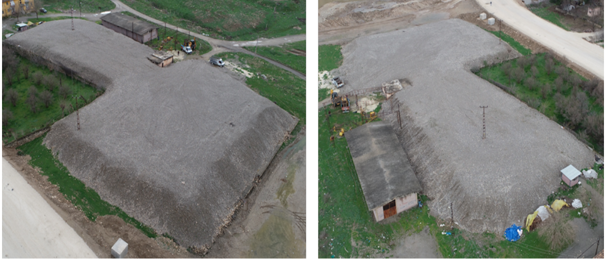
Resim 21. Mardinike Külliyesi Yapı Kalıntılarının Su Altında Koruma Uygulamaları Sonrası Görünümü (Yazar Arşivi)
