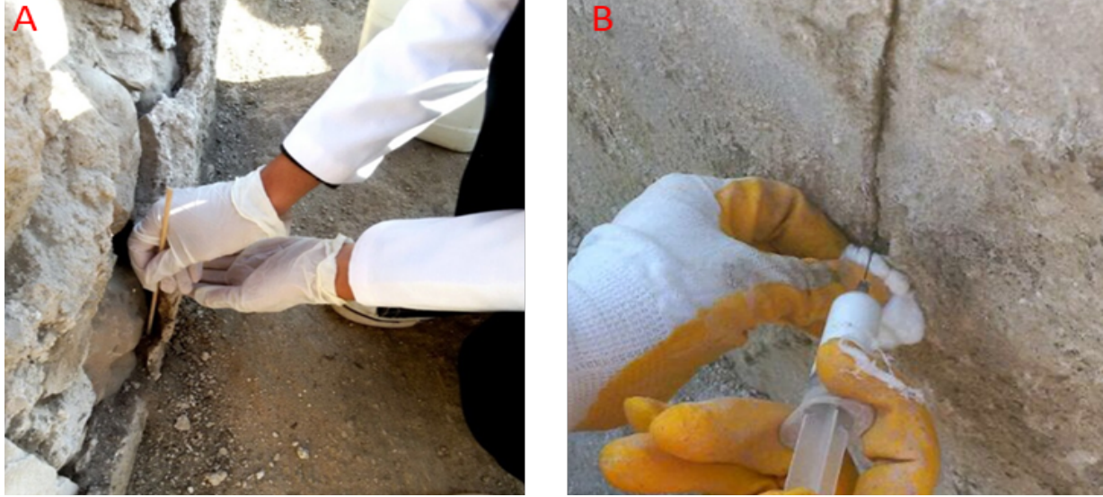
Resim 16. Mardinike Külliyesi Sıva Kalıntılarının Sağlamlaştırılması, Resim 16A: Çatlak ve Boşlukların İçlerine Dolan Toz, Toprak ve Harç Artıkları Temizlenmesi, Resim 16B: Akrilik Reçine (Primal AC 33 Su İçinde %20) Enjekte Edilmesi (Yazar Arşivi)
