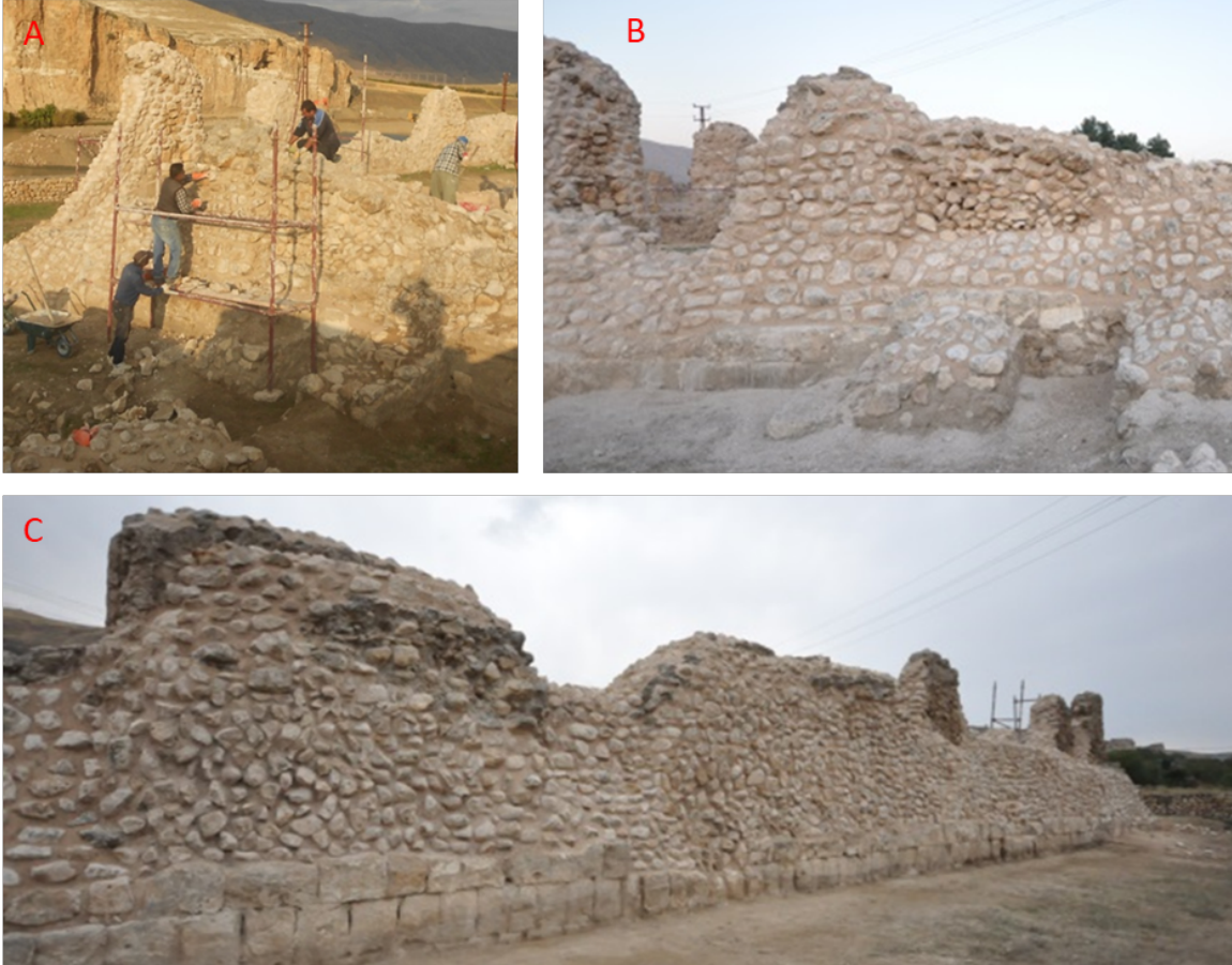
Resim 13. Mardinike Külliyesi Yapı Kalıntılarının Duvar Örgülerindeki Bölgesel ve Birim Eleman Kayıplarının Tamamlanması, Resim 13A: Duvar Örgülerindeki Tamamlama Uygulamaları, Resim 13B-13C: Duvar Örgülerindeki Tamamlama Uyguları Sonrası (Yazar Arşivi)
