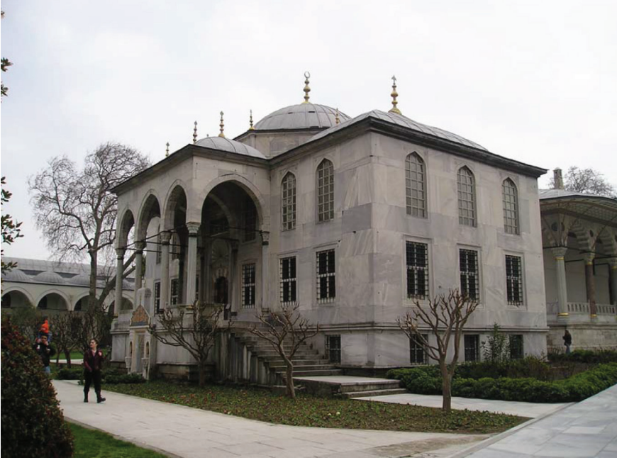
Resim 6. Kütüphanenin kuzeydoğu ve kuzeybatı cepheleri
