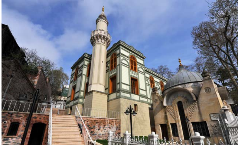
Şekil 2. Ertuğrul Tekke, Beşiktaş. Restorasyon Sonrası. 26
