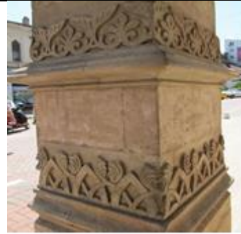
Resim 9. Giriş Cephesindeki Sütun Süslemelerinden Ayrıntı
