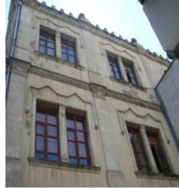
Resim 11. Eski Belediye Sarayı Binası Batı Cephe
