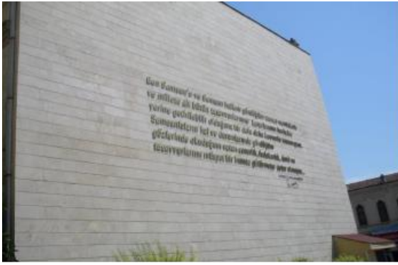
Resim 18. Eski Belediye Sarayı Binası Güney Cephe
