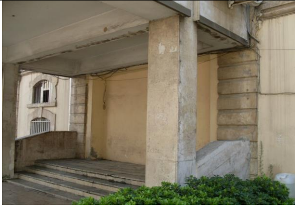
Resim 14. Eski Belediye Sarayı Binası Batı Cephe
