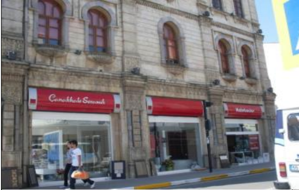
Resim 16. Eski Belediye Sarayı Binası Kuzey Cephe Süslemelerinden Ayrıntı
