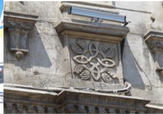
Resim 17. Eski Belediye Sarayı Kuzey Cephe Giriş Katı
