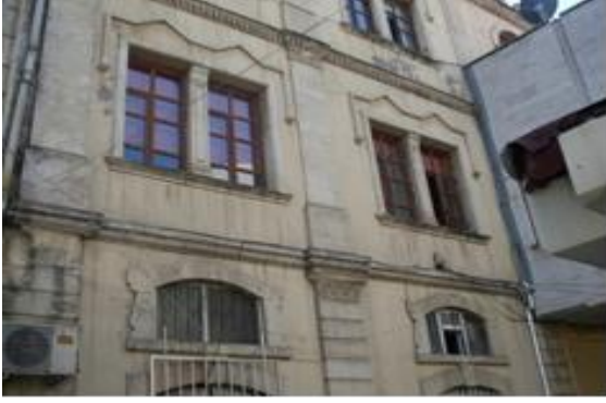
Resim 12. Eski Belediye Sarayı Binası Batı Cephe
