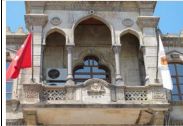
Resim 4. Eski Belediye Sarayı Binası 2. Kat Balkon
