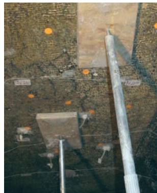
Malta 6001 enjeksiyonu ile tessera ve yatak harcı sağlamlaştırma çalışmaları
