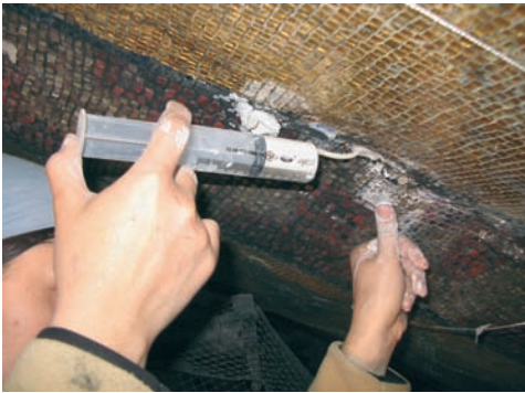
Malta 6001 enjeksiyonu ile tessera ve yatak harcı sağlamlaştırma çalışmaları
