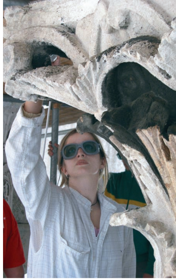
Resim 5. Fiber optik sayesinde girift yüzeylerde bile temizlik yapılabilir.
