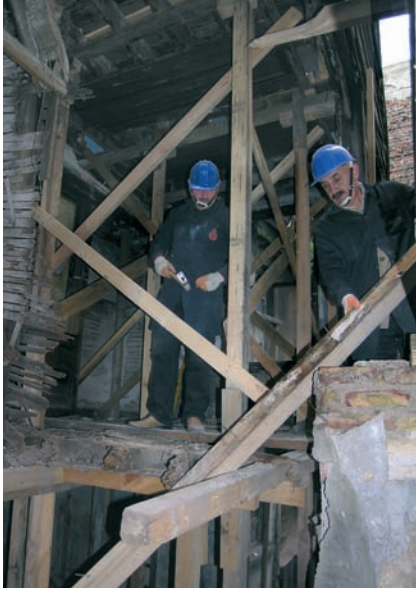
Şekil 6. Geçici askı iskelesinin kurulması (2008)
