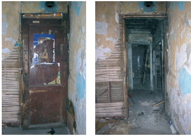
Şekil 15. Birinci kat, sökümü yapılan K14-1K09 numaralı ahşap kapı
