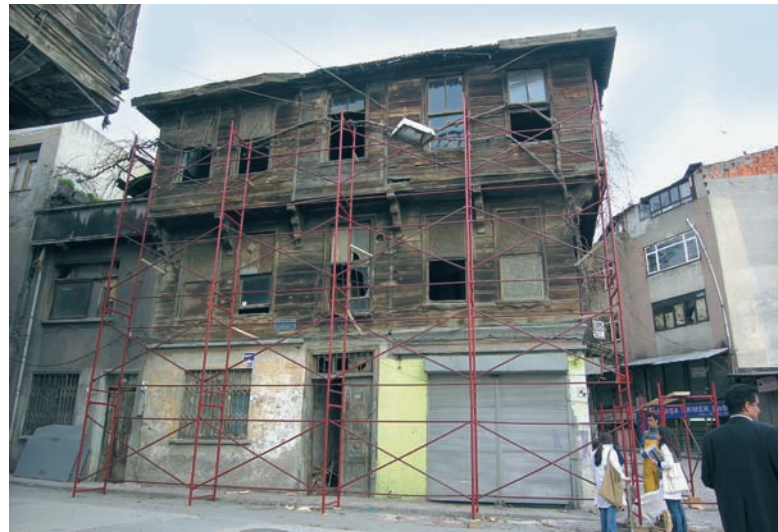
Sekil 1. Çalışma konusu ahşap yapının uygulama öncesi genel görünümü (Mart 2008)
