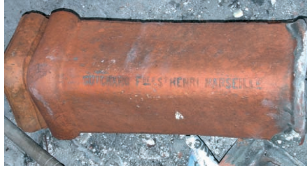
Şekil 29. Çatıdan indirilerek sağlam olanları ayrılan Marsilya tipi kiremitler
