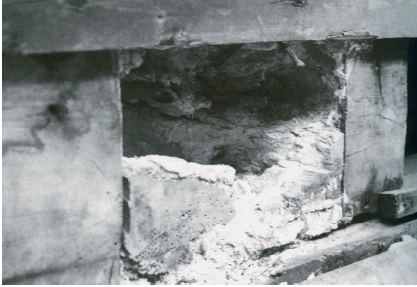
Resim 1. Beyaz çürüklük, normalde yumuşak odundan ziyade sert odunda daha fazla görülür. "White rots are more common in hardwoods than in softwoods" (Ridout, 2004)
