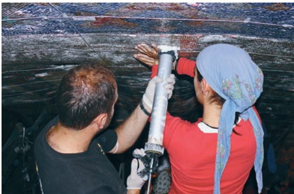
Malta 6001 enjeksiyonu ile tessera ve yatak harcı sağlamlaştırma çalışmaları
