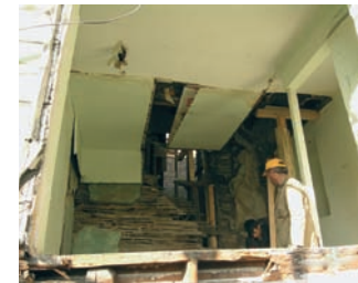
Şekil 24. Kaldırılan muhdes kaplama elemanları (ZK07 mekanı; Ekim 2008)
