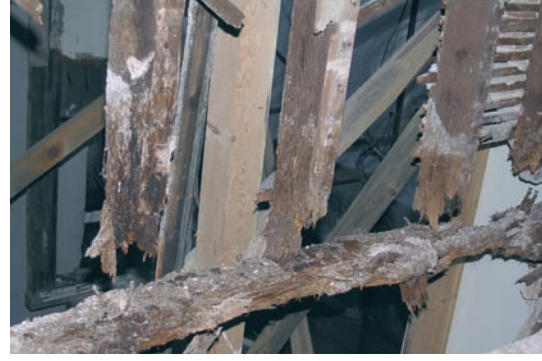
Şekil 20. Taşıyıcı iş- levini yitiren ahşap ele- manlar
