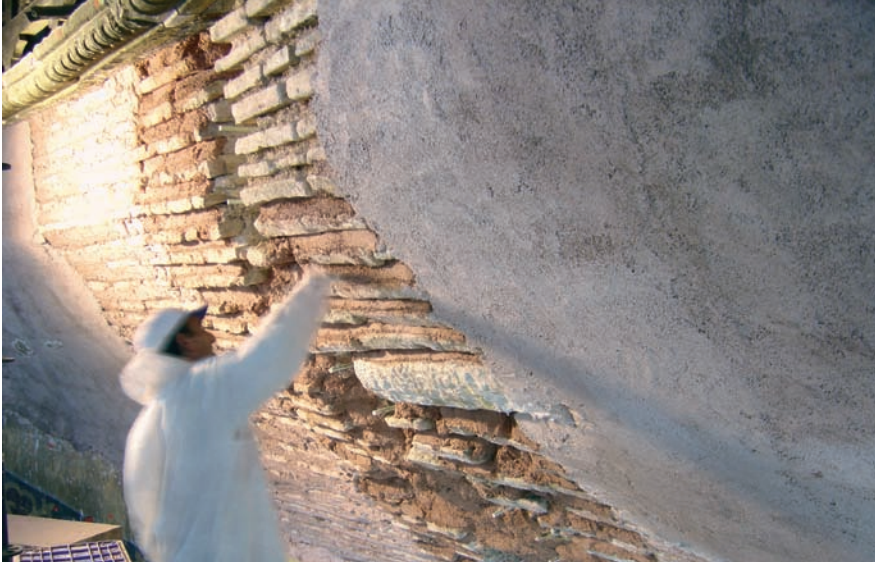
Güneybatı Serafimi'nde sıva uygulaması
