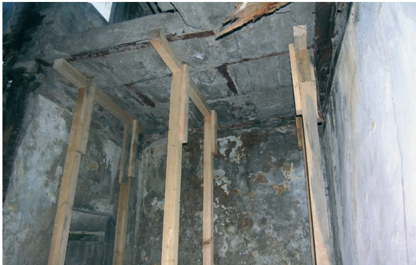
Şekil 5. Muhdes beton döşemenin desteklenmesi (Temmuz 2008)
