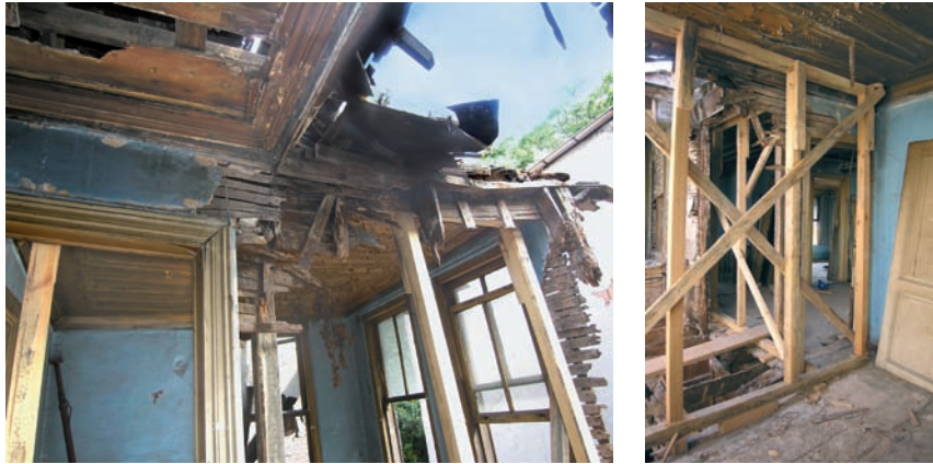
Şekil 4. Yapının kuzey bölümü, 2K04 mekanının geçici olarak desteklenmesi (2008)
