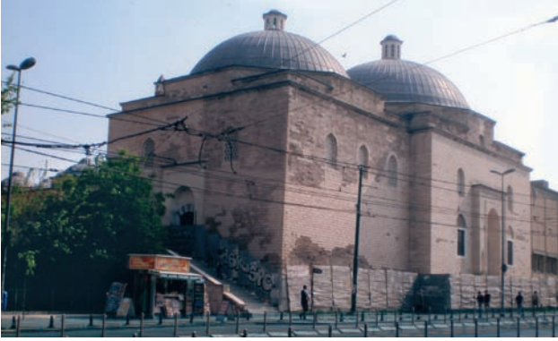
Resim 19. Hamamın onarım sonrası görünüşü
