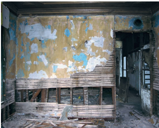
Şekil 10. Birinci kat 1K09- D1 duvarının kısmi söküm sonrası durumu (2008)
