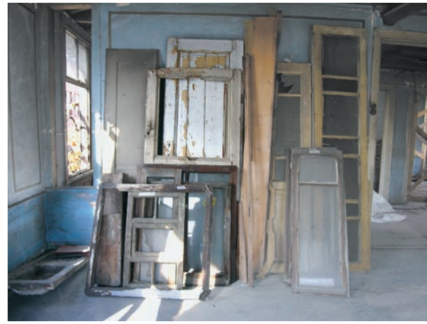
Şekil 16. Onarılacak yerlerine yerleştirilmek üzere depolanan yapı elemanlarının bir bölümü
