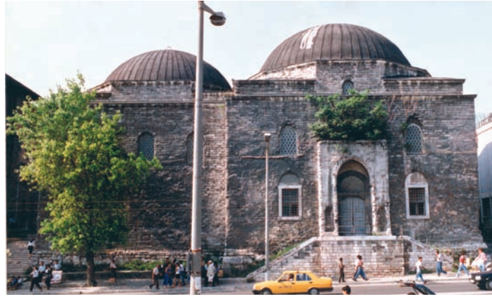
Resim 14. Onarım öncesi hamamın ana caddeye bakan cephesi, 1996
