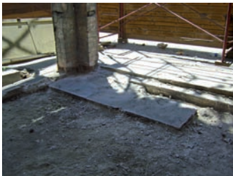
Şekil 23. Kismen korunmuş özgün mermer döşeme (ZK09 mekanı; 2008)
