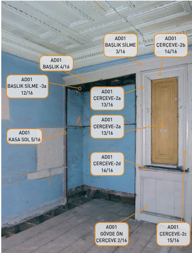
Şekil 13. AD01-2K02 dolabı, söküm envanteri (Ekim 2008)
