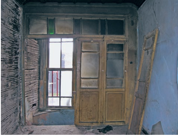
Şekil 14. İkinci kat, AB01-2K01 numaralı dönem eki ahşap bölmenin sökümü
