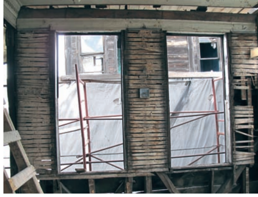
Sekil 17. 2K02-D3 duvarı, pencere ve sıva sökümü (sol: Nisan 2008, sağ: Ekim 2009)
