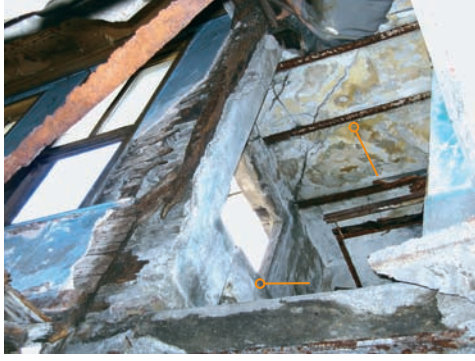
Şekil 19. Ek beton döşeme ve kargir duvar
