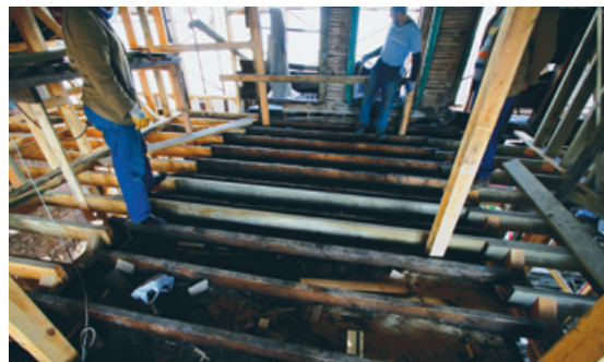
Sekil 33. Çatı katındaki döşeme ve dikmelerin değişimi ve takviyesi
