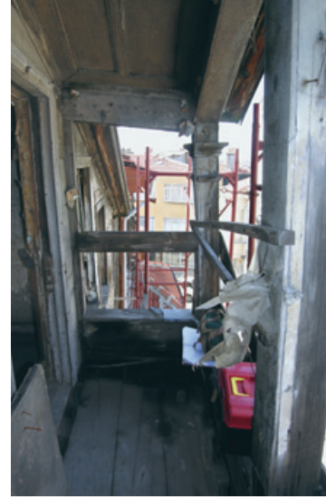
Sekil 12. Çatı katı ve balkonun görünümü
