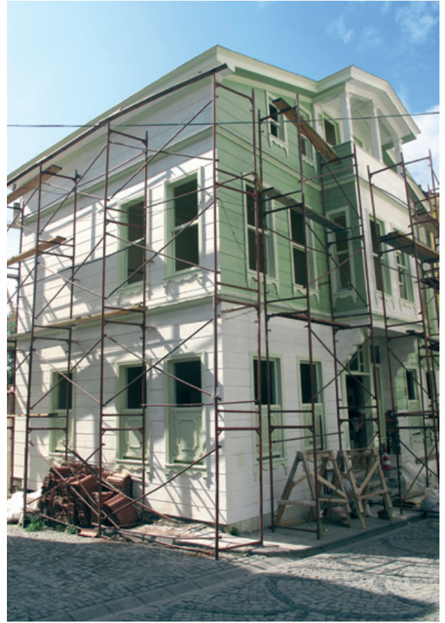
Sekil 46. İç kapıların montajı, cephelerin iç ve dış astar sonrası nefes alan nitelikte boya ile boyanması
