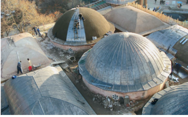
Resim 14. Kurşunların yapımı sırasında kubbe-lerin görünümü
