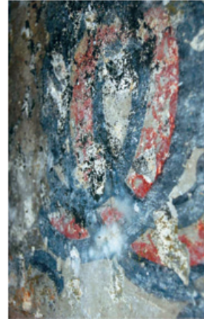
Resim 4. Kemirlerde oluşan bozulmalar
