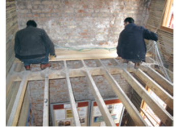
Şekil 42. Çıkma altındaki eliböğünde çıtalarının ve döşeme kaplamalarının montajı
