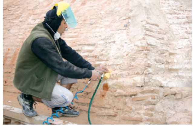
Resim 11. Kubbe ve tonozlarda yapılan enjeksiyon uygulaması
