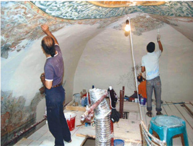
Resim 30,31. Orijinal duvar resimlerinin arasındaki eksiklerin rötuşlanması
