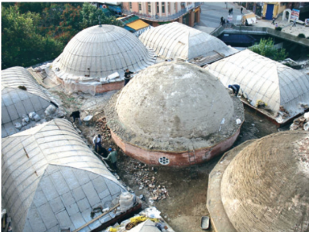
Resim 8. Kubbe ve tonozların restorasyon sırasındaki görünümü
