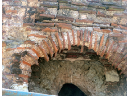
Şekil 19-20-21. MB.46 no.lu örneğin alındığı kısım (tuğla boyutları 32x16x 3cm, derz aralıkları 6cm (sol), GY.12 no.lu örneğin alındığı kısım (orta), SAY.3 no.lu örneğin alındığı kısım (tuğla boyutları 24x12x4cm, derz aralıkları 4 cm; sağ)
