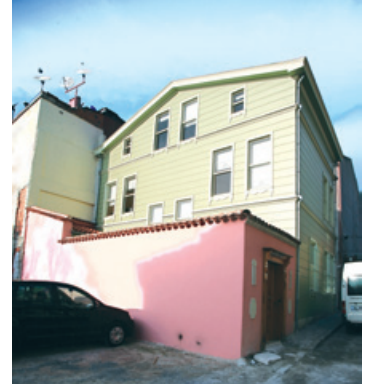
Şekil 51. Yapının genel görünümü
