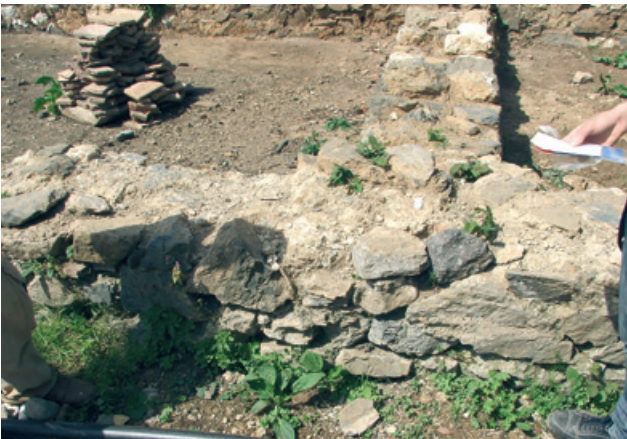
Şekil 6-7. GY.15 no.lu örneğin alındığı moloz taş örgülü duvar (sol), TAY.11 no.lu hidrolik kireç bağlayıcılı örneğin laboratuvar görüntüsü
