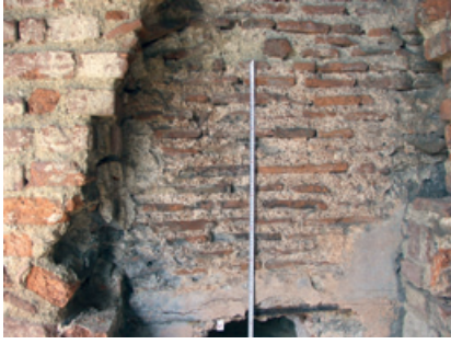
Şekil 19-20-21. MB.46 no.lu örneğin alındığı kısım (tuğla boyutları 32x16x 3cm, derz aralıkları 6cm (sol), GY.12 no.lu örneğin alındığı kısım (orta), SAY.3 no.lu örneğin alındığı kısım (tuğla boyutları 24x12x4cm, derz aralıkları 4 cm; sağ)
