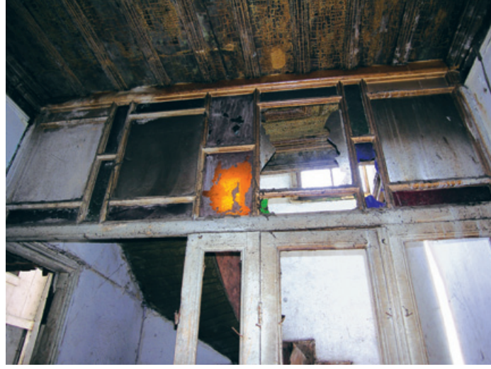
Şekil 9. 1.kat merdiven holündeki dönem eki ahşap bölme
