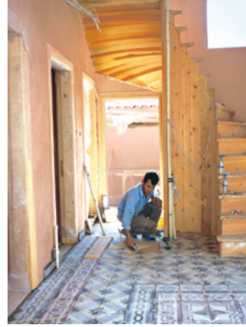
Sekil 45. Ta- mir edilen gi- riş kapısının öz- gün kilit aksamı, montajı ve ze- min katta karo mozaik döşeme yapılması
