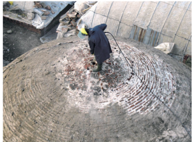
Resim 9. Kubbelerde kurşun altı sivanın temizliği
