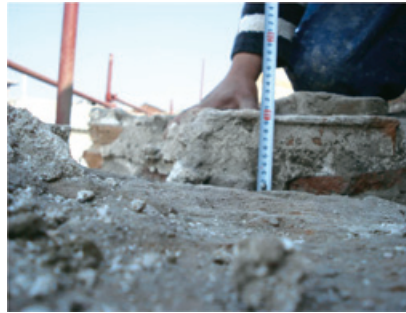
Resim 3. Duvarlarda 15cm'yi bulan kaymalar
