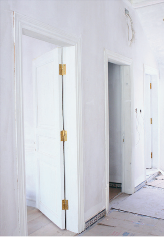
Sekil 46. İç kapıların montajı, cephelerin iç ve dış astar sonrası nefes alan nitelikte boya ile boyanması
