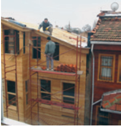
Şekil 41. Çatı onarımı ve çinko işlerinin ardından kiremitlerin döşenmesi ve balkonun tamiri
