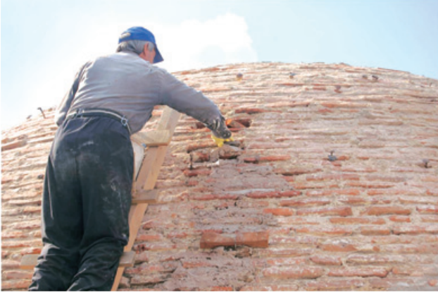
Resim 10. Çatlakların dikiş yöntemi ile tamir edilmesi
