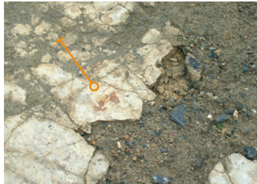
Şekil 15-16. ÇUY.8 no.lu örneğin görüntüsü, malta taşı döşeme kaplaması ve altındaki tesviye harcı (sol), KAY.3 no.lu suni taş örneğinin alındığı kısım (sağ)
