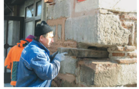
Resim 16. Beden duvarlarını çevreleyen hatılların görünümü
