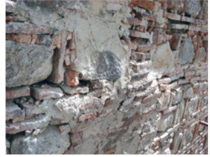
Resim 7. Derzlerdeki çimento katkıli eklentiler
