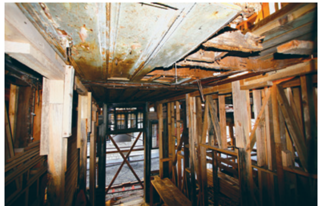
Şekil 29. Yapıdaki niteliksiz eklerin ayıklanması ve sağlam kalabilen parçalar korunduktan sonra askıya alma çalışmaları
