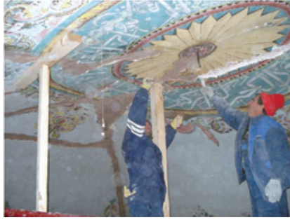
Resim 20. Ön sağlamlaştırma için duvar resimlerindeki çatlakların sıvanması
