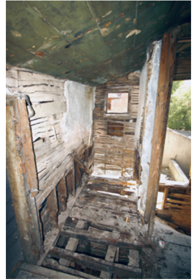
Sekil 30. Yapının askıya alınmasının ardından taşıyıcı sistem ve döşemelerin değiştirilmesi ve takviyesi, kalın betonarme döşemeye teşkil edilen çatı katındaki tuvalet mekânının kaldırılması
