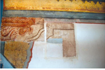
Resim 8. 20.yy katmanının altından ortaya çıkan 19.yy'a ait boya katmanı
