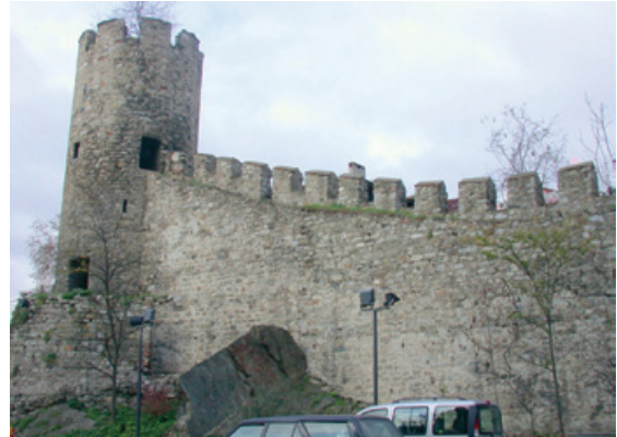
Şekil 2. Kara tarafındaki burç ve duvarlar
