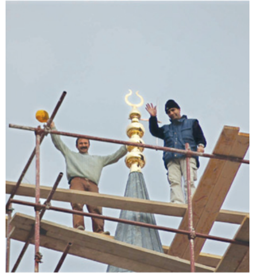
Resim 20. Minare aleminin takılması
