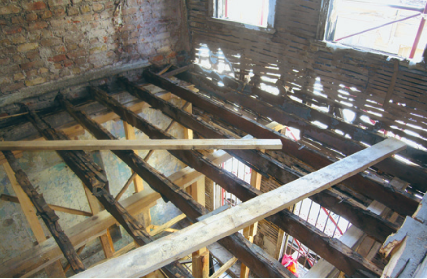
Sekil 30. Yapının askıya alınmasının ardından taşıyıcı sistem ve döşemelerin değiştirilmesi ve takviyesi, kalın betonarme döşemeye teşkil edilen çatı katındaki tuvalet mekânının kaldırılması
