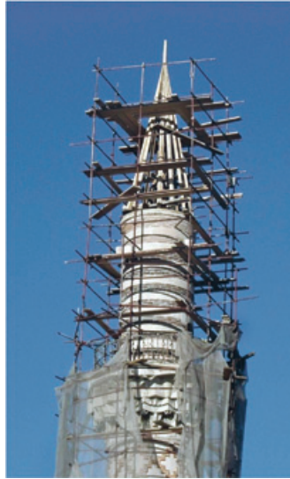
Resim 19. Minarenin söküldükten sonraki görünümü
