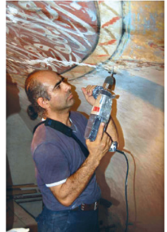
Resim 22,23. Duvar resimlerinin sağlamlaştırılması için kullanılan paslanmaz çelik saplamalar
