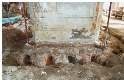
Resim 17. Fil ayaklarındaki hatıl boşluklarının görünümü
