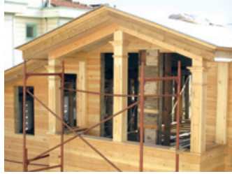
Şekil 41. Çatı onarımı ve çinko işlerinin ardından kiremitlerin döşenmesi ve balkonun tamiri
