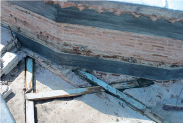
Resim 12. Kubbe hatıllarının değiştirildikten sonraki görünümü
