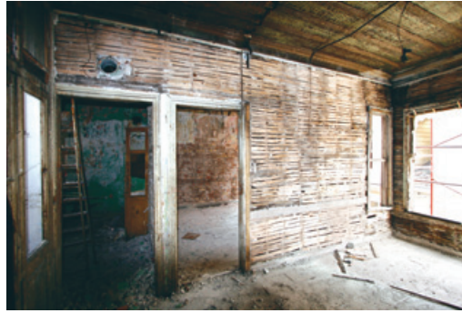
Şekil 28. 1.kat duvarlarındaki çimentolu siva raspası sonrasında döşeme kaplamalarının sökülmesi
