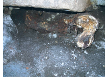
Resim 5. Hatıl boşluklarından çıkarılan bitki kökleri
