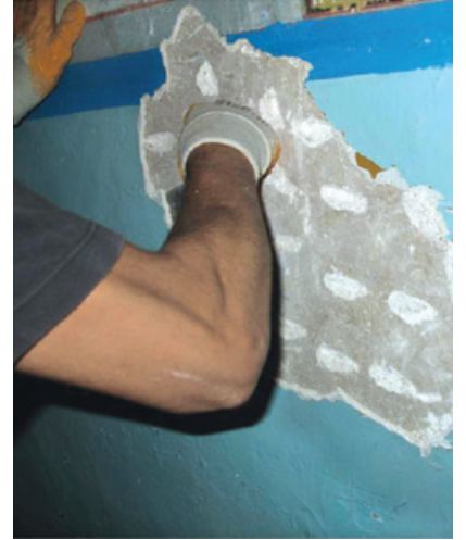
Resim 11. Zemine yakın yerlerde bulunan 0,5cm'lik çimento ve üzerindeki yağlı boya katmanı
