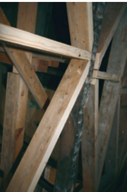
Sekil 31. Yapı askıya alındıktan sonra dikmelerin takviyesi ve değişimi
