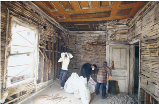
Şekil 29. Yapıdaki niteliksiz eklerin ayıklanması ve sağlam kalabilen parçalar korunduktan sonra askıya alma çalışmaları
