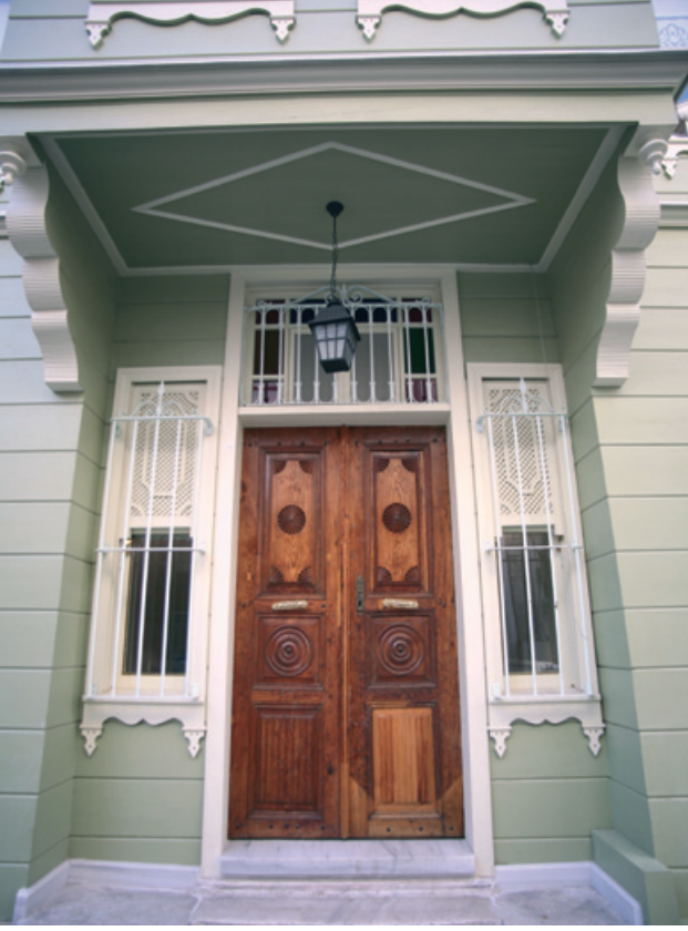
Şekil 47. Giriş kapısı ve giriş holünün görünümü
