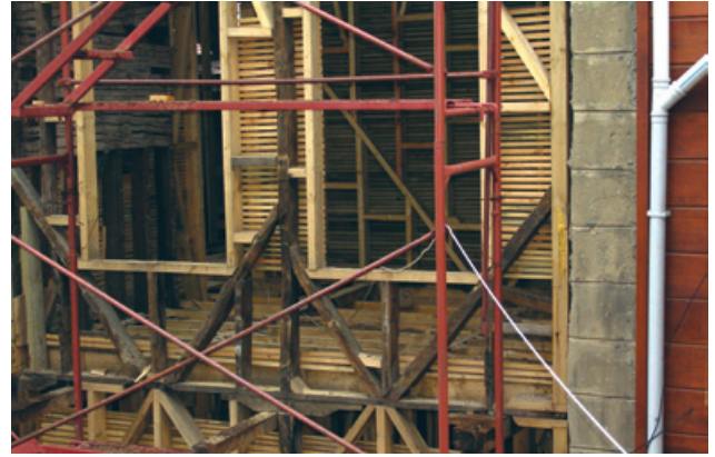
Sekil 30. Yapının askıya alınmasının ardından taşıyıcı sistem ve döşemelerin değiştirilmesi ve takviyesi, kalın betonarme döşemeye teşkil edilen çatı katındaki tuvalet mekânının kaldırılması
