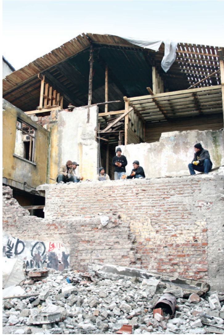
Şekil 35. Bahçeye yapılan niteliksiz ekin kaldırılması
