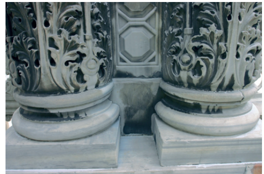
Resim 5. Mermer yüzeylerde alçıtaşı kabuk oluşumu
