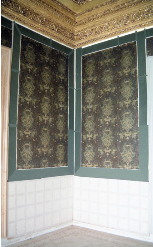
Resim 13. Hazırlanan ahşap karkas sistem ve duvar kağıtlarının yerleştirilmesi
