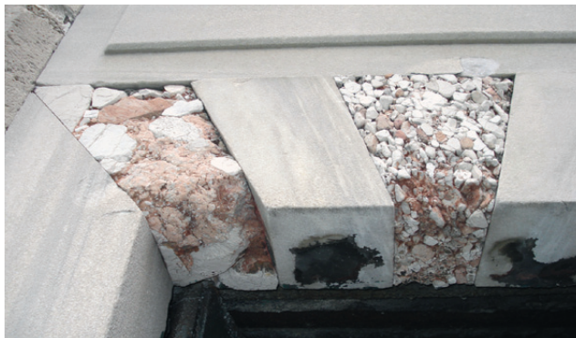
Şekil 29. Avluda kemer taşı olarak kullanılan Hereke pudinginin çakıllarındaki kopma ve dökülmeler
