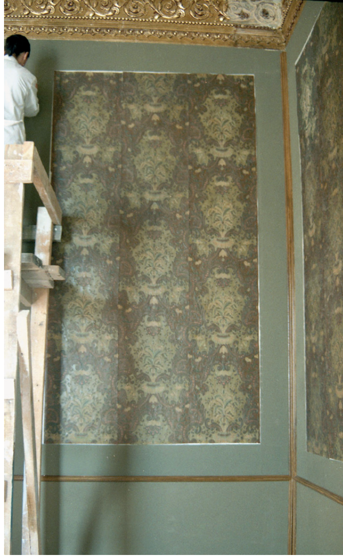
Resim 15. Montajı tamamlanan duvar kağıtlarına son rötuşların yapılması
