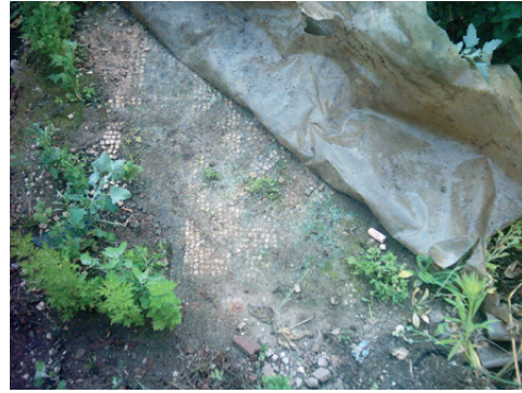
Resim 12. Naylon örtünün altında yoğun bitki oluşumu ve yatak harcından ayrılmış durumdaki mozaikler
