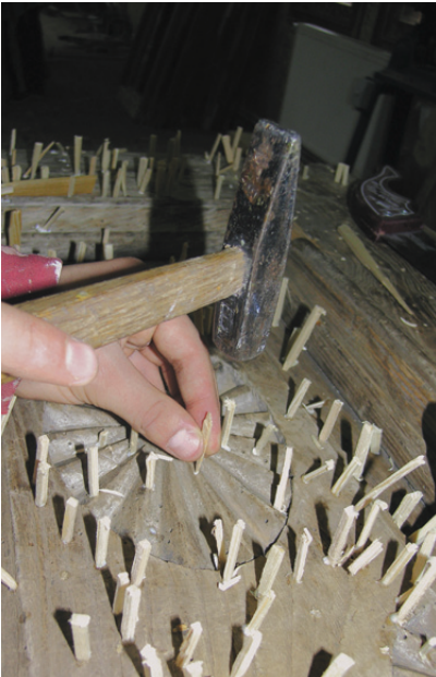
Ahşap kapı onarımı
