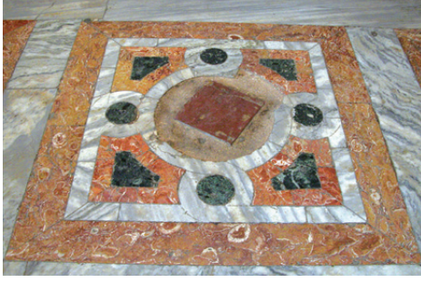
Şekil 11. Kariye Müzesi'nin iç mekân yer döşemesinde kullanılan Gebze Rudistli kireçtaşı
