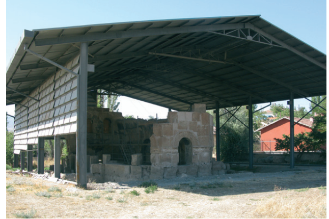
Resim 17. Rüzgâr, eğimli gelen kar ve yağmura karşı koruyucu üst örtüde oluşturulan paneller (Niğde, Konstantin Helena Kilisesi)
