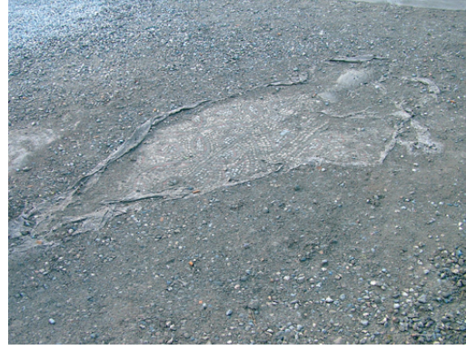
Resim 7. Duvar resmi bulunan yüzeyde tekrarlanan tuz kristallenmesi
