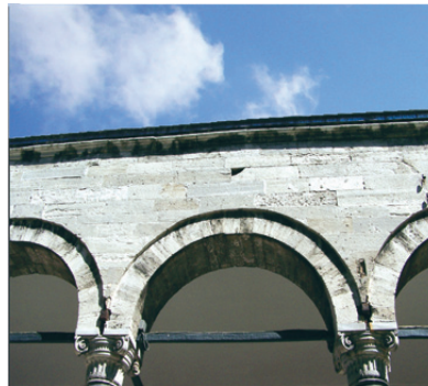
Şekil 23. Avlu kemerlerinde Bakırköy küfeki taşının kullanımı
