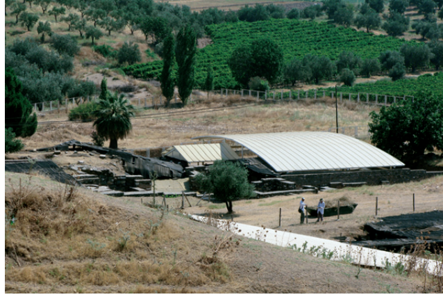
Resim 5. Koruyucu çatı ile koruma altına alınan yapı kalıntıları (Sardis Kazısı)
