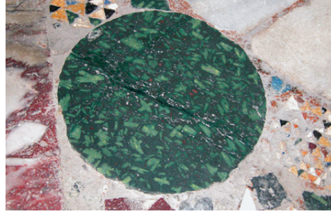
Şekil 12. Yer döşemesinde yuvarlak disk şeklinde kullanılan eski yeşil porfir
