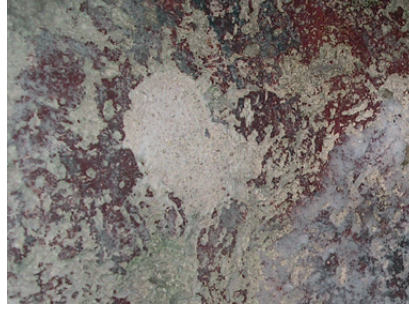
Resim 7. Duvar resmi bulunan yüzeyde tekrarlanan tuz kristallenmesi
