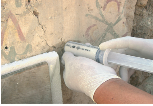
Resim 18. Sıva-duvar arası sağlamlaştırma
