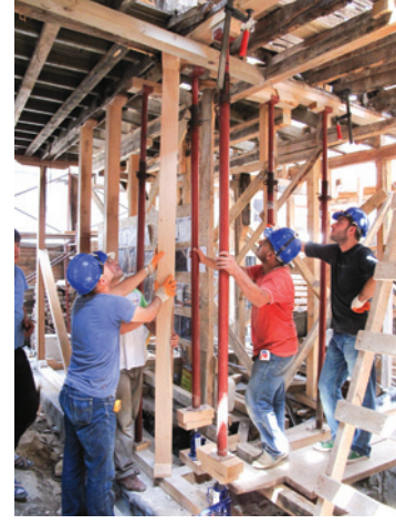
Resim 15. Taşıyıcı sistemin krikolar yardımıyla kaldırılarak teraziye alınması
