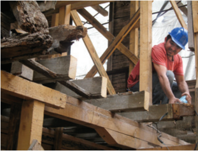
Resim 35. Kirişlerin hasarlı uç kısımlarının kesilmesi
