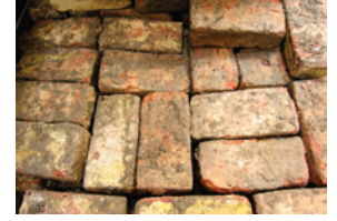
Resim 4. Sağlam olarak çıkarılarak kenara ayrılan harman tuğlaları
