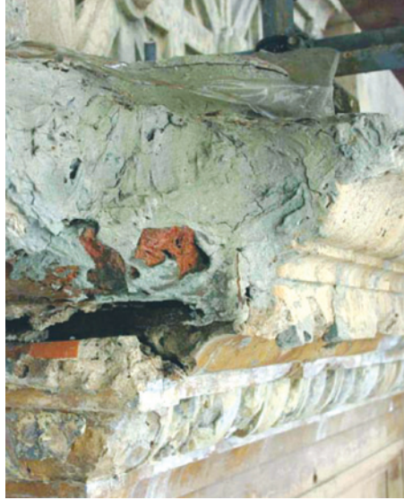
Şekil 10 ve 11. Tarihi bir yapının kornişinden detay: Solda kırılan bölümün bütünlüme için uygun olmayan Portland çimentosu bir harçla onarıldığı görülüyor. Sağda aynı köşenin özgüne uygun Roma çimentosu harç ve çekme (sürme) kalıpla onarımı ( Roman Cement - Advisory Note , 2006: 20-21).
