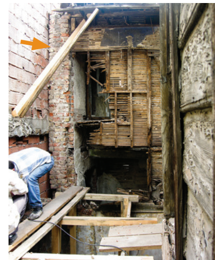
Resim 2. Yangın duvarının söküm öncesi durumu
