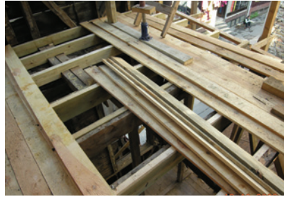
Resim 39. Ayrılan sağlam döşeme kaplamaları Resim 40. 2K02 mekânı döşeme kirişlerinin onarımı
