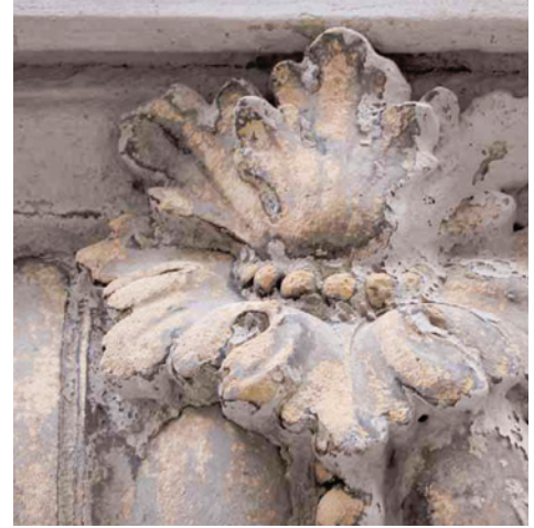
Şekil 7 ve 8. Roma çimentosu bağlayıcılı dökümlerde elde edilebilen narin detay niteliği diğer çimento bağlayıcılı harçlara göre çok daha yüksektir. Her iki örnekte bezemenin üzerine kaplayarak detay niteliğini bozan geç tarihli yüzey boya müdahaleleri kısmen temizlenmiştir. ( Roman Cement - Brochure , 2005: 11, 14).
