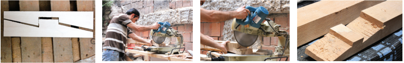
Resim 18. Kurt ağı birleşim detayının uygulanması
