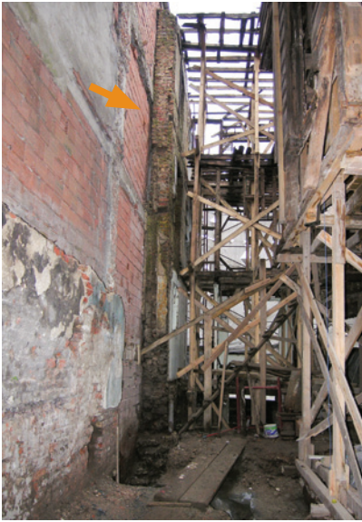
Resim 1. Yangın duvarının uygulama öncesi durumu
