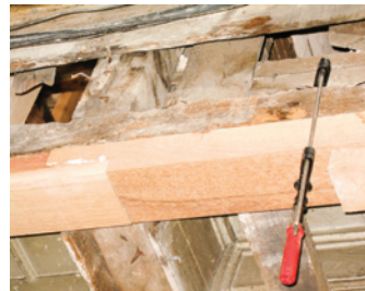
Resim 30. Yeni meşe yastığın eklenmesi
