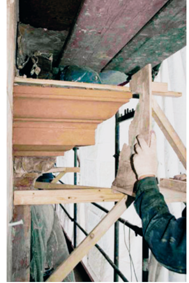
Şekil 10 ve 11. Tarihi bir yapının kornişinden detay: Solda kırılan bölümün bütünlüme için uygun olmayan Portland çimentosu bir harçla onarıldığı görülüyor. Sağda aynı köşenin özgüne uygun Roma çimentosu harç ve çekme (sürme) kalıpla onarımı ( Roman Cement - Advisory Note , 2006: 20-21).
