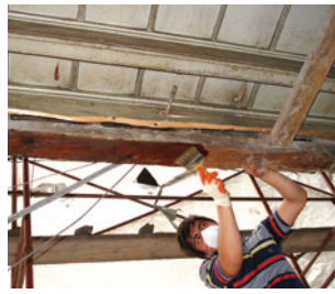
Resim 29. Yastığın yerinde empenye edilmesi
