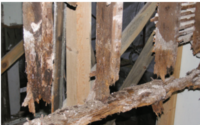
Resim 16. Taşıyıcı işlevini yitmiş olan elemanlar
