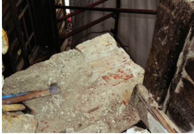
Resim 6. Yangın duvarının sökümü
