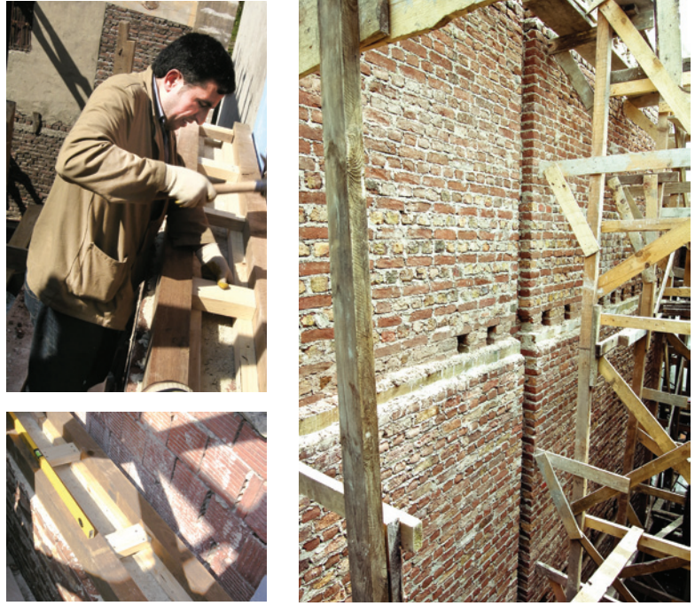
Resim 9. Duvarın içerisine kat seviyelerinde meshe hatılların yerleştirilmesi
