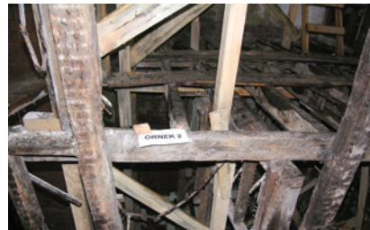
Resim 17. Cins tayini için ahşap elemanlardan örnek alımı
