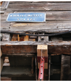
Resim 28. Batı duvarının teraziye alınması
