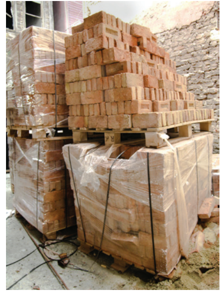
Resim 7. Özgünleri ile aynı boyuttaki yeni tuğlalar
