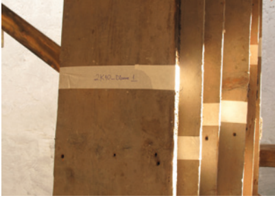
Resim 39. Ayrılan sağlam döşeme kaplamaları Resim 40. 2K02 mekânı döşeme kirişlerinin onarımı
