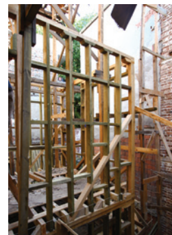
Resim 30. Yeni meşe yastığın eklenmesi
