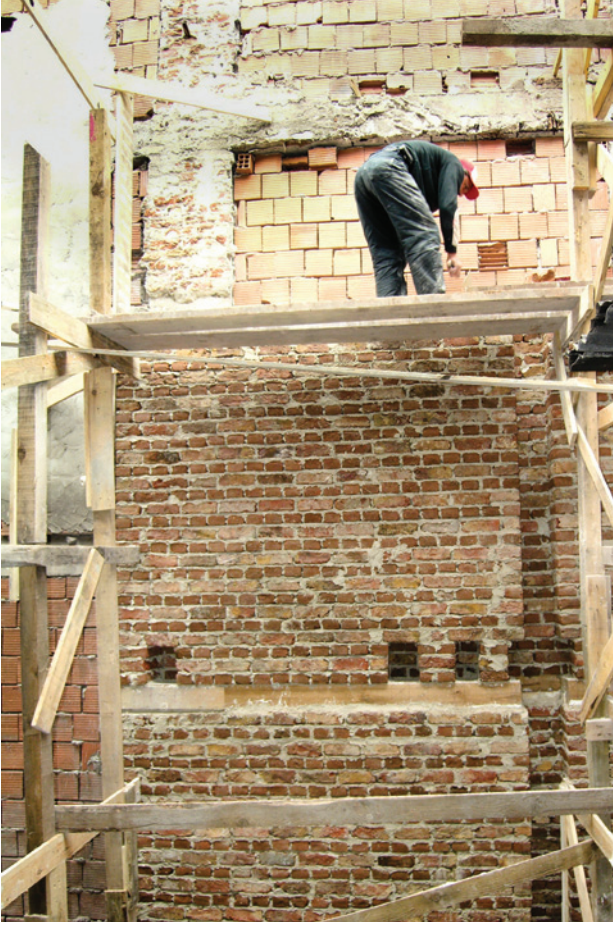
Resim 12. Yangın duvarının yeniden örülmesi
