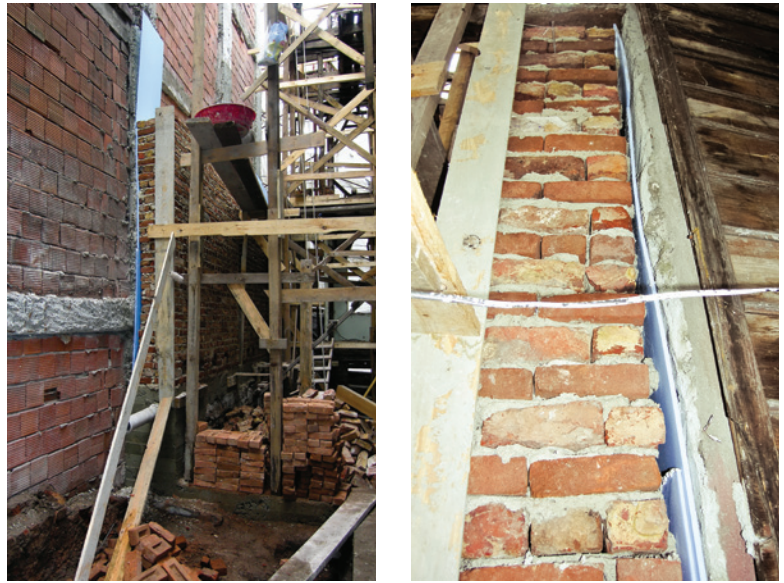
Resim 10. Yangın duvarı ile komşu yapı arasında yerleştirilen sıkıştırılmış levhalar
