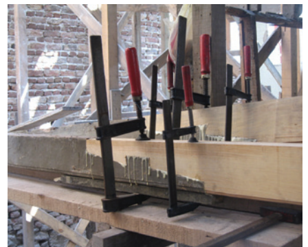
Resim 37. Bütünleme tekniğinin kirişlerde uygulanması
