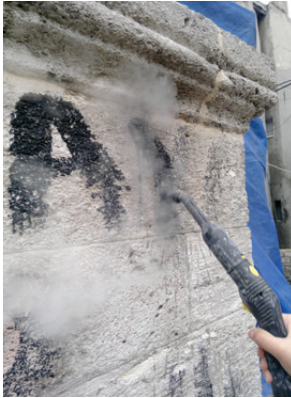
Buhar yöntemi ile cephe temizliği
