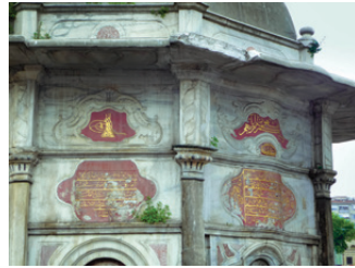
Sine-i Perver Valide Sultan Çeşmesi Restorasyon Öncesi Kitabe Bölümü
