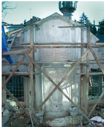
Kurna bölümünde yapılan kot çalışması
