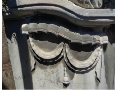
Cephede oluşan kabuklanmalar
