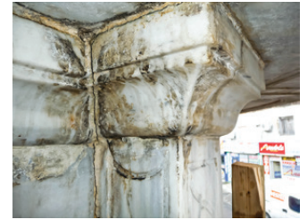
Çeşme yüzeyindeki yüzey kirlilikleri ve niteliksiz dolgular
