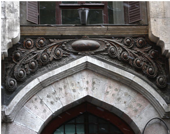
Şekil 14. Çeşitli derecelerde kirlenme örnekleri (KUDEB Rest. ve Kons. Lab., 2010-2012)
