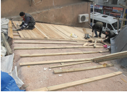
Kiremit altına kaplama çakılması uygulaması
