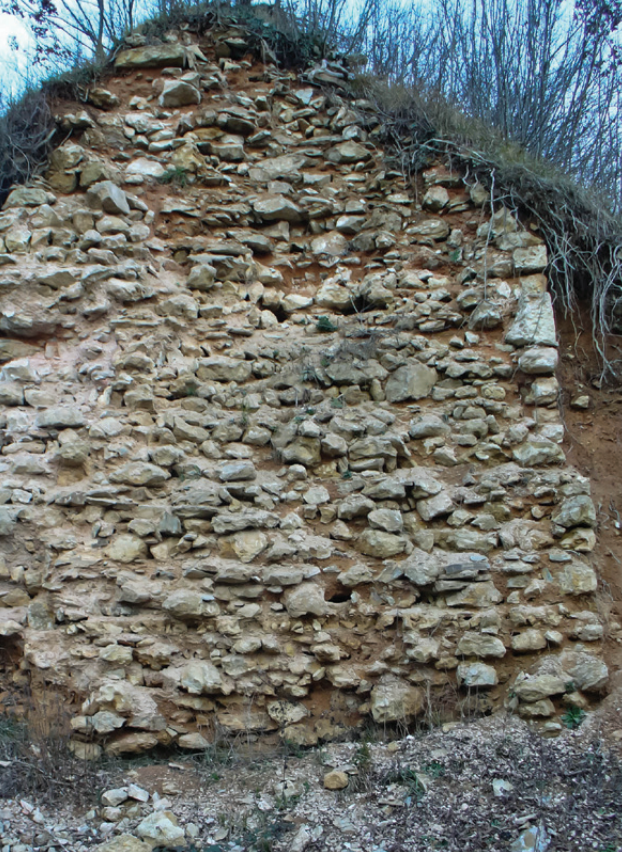
Şekil 5. a) Anastasios surları iç yapısı
