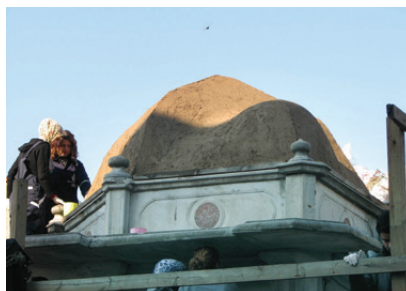
Kurşun altı toprak harç serilmesi
