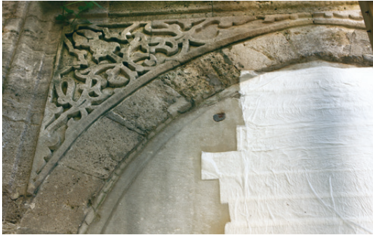
Şekil 15. Mermer üzerinde AB57 uygulaması (KUDEB Rest. ve Kons. Lab., 2009)
