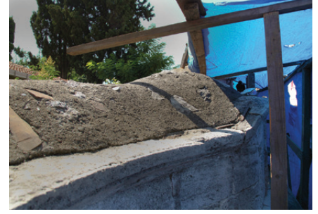
Üst örtüde daha önce yapılan çimentolu sıva
