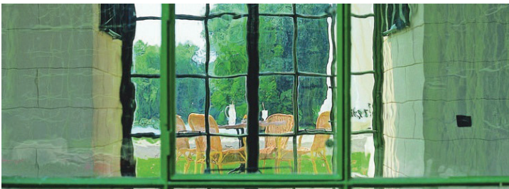
Resim 8. Restorasyon camı ile restore edilmiş Orangerie Sarayı, Schwerin, Almanya'dan bir detay fotoğrafı. 10
