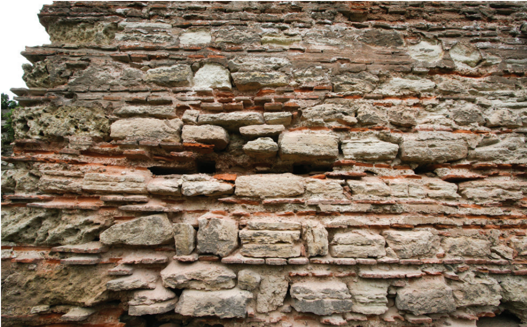
Şekil 2. Yapının Güneydoğu cephesi tuğla sıralarındaki farklılaşmalar
