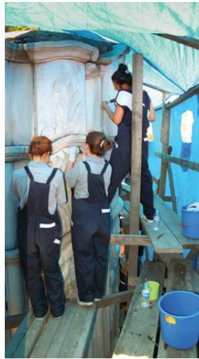
Cephede yapılan temizlik uygulaması
