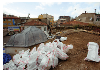
Üst örtü üzerine yapılan çimentolu sıva
