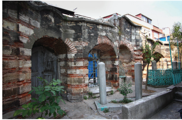
Arka cepheden görünüm
