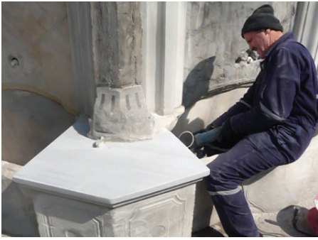
Yeniden imal edilen seki taşlarının monte edilmesi
