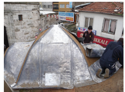
Kurşun kaplama uygulaması
