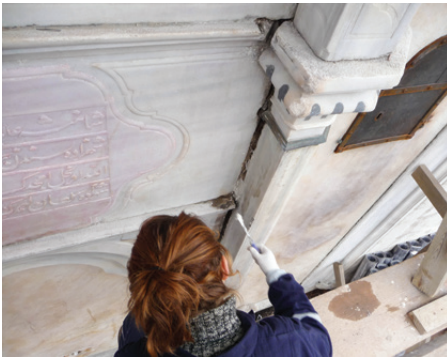
Dolgu ve derz yapılması
