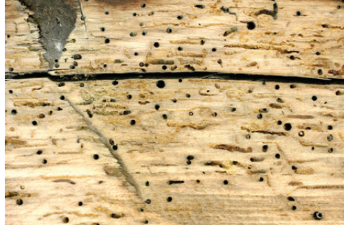
Şekil 13. Organizma faaliyetine bağlı olarak, ahşapta görülen bozulmalar ve kesit kaybı (KUDEB Rest. ve Kons. Lab., 2010)
