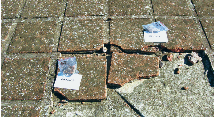
Şekil 8. Esere zarar vermemek için, yerindeki ile aynı özellikte ise, kırılmış tuğlalardan örnek alınması yeterli olur (KUDEB Rest. ve Kons. Lab., 2007).
