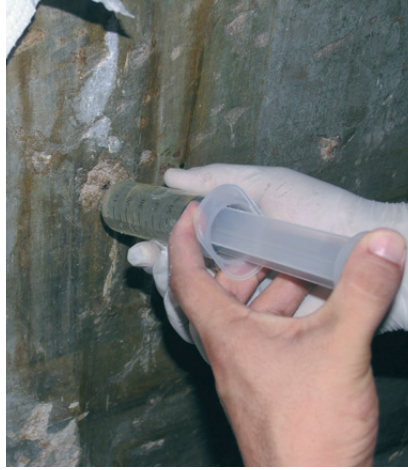
Şekil 17. Kalem işi konservasyonu uygulaması, sıva tabakasının Paraloid B72 ile sağlanlaştırılması (KUDEB Kayserili Ahmet Paşa Konağı- duvar resimlerinin konservasyonu, 2008)
