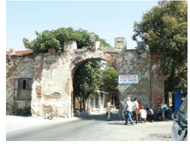
Şekil 9. Rami kışlası 8 no.lu anakol avlu giriş kapısı, Akant Mimarlık Arşivi, 2006.
