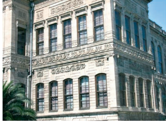
Şekil 10. Dolmabahçe Sarayı batı cephesi pencerelerinde mor ötesi ve görünür ışığı belirli bir oranda engelleyen özgül renkli camlar ve stor perdeler
