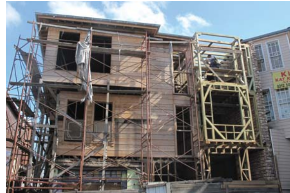
Resim 20. Karkas sistemin yapımı
