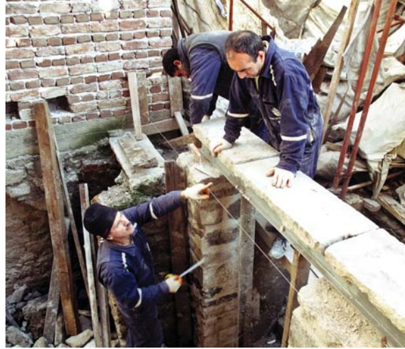
Resim 17. Özgün taş silmenin tekrar yerine yerleştirilmesi
