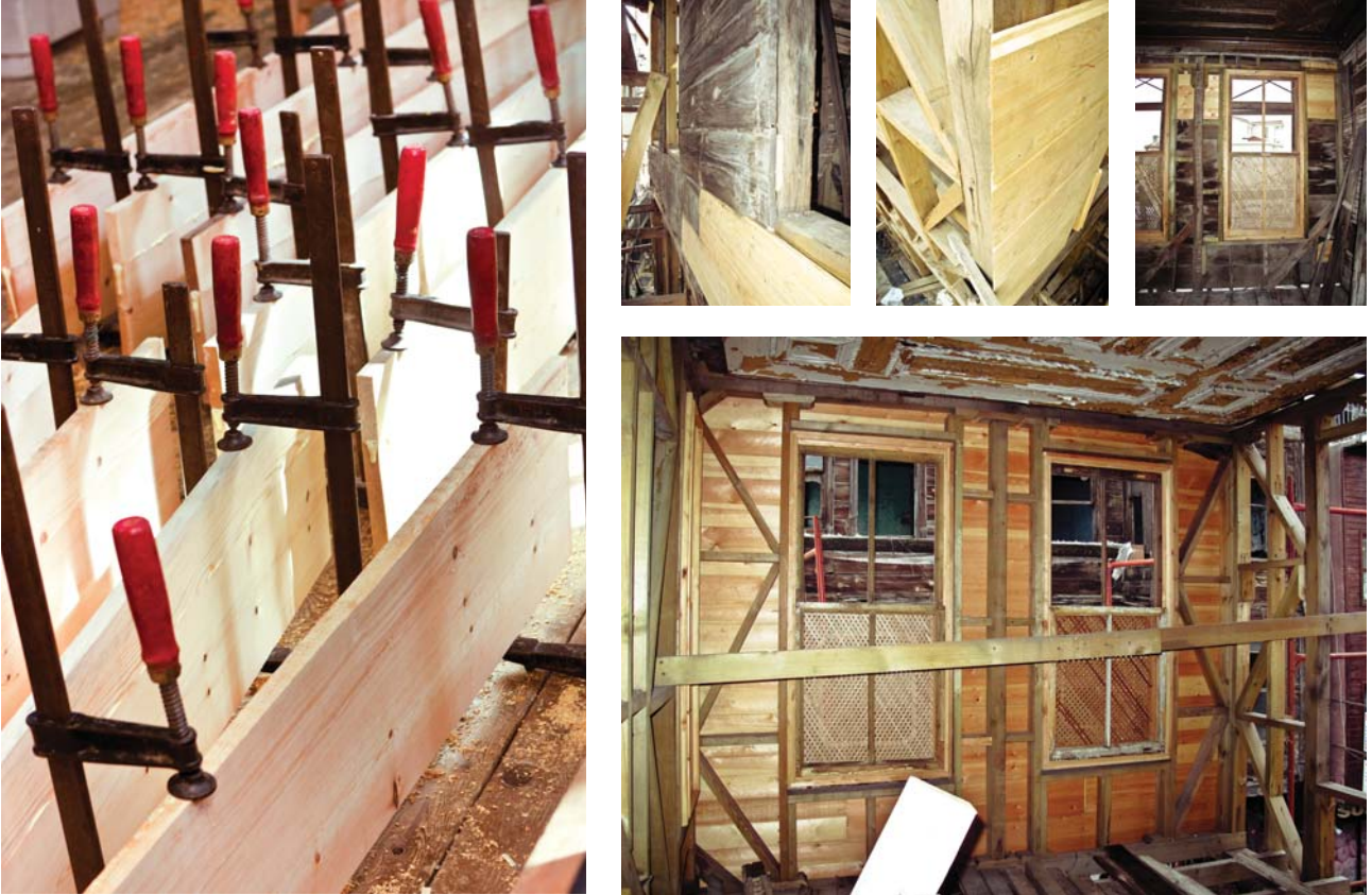
Resim 9. Atölye ortamında cephe kaplamalarının hazırlığı
