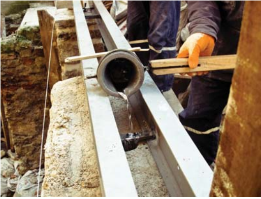
Resim 16. Bağlantı yuvalarının kurşun ile doldurulması
