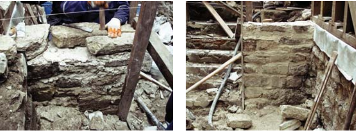
Resim 14. Kaba yonu taş duvarın örülmesi
