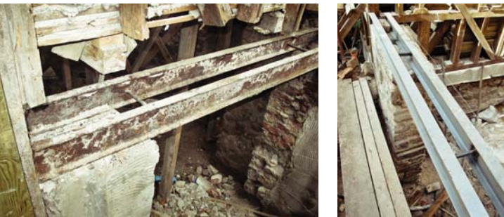
Resim 15. Sökülen demir putrellerin yerine kirişlerin yerleştirilmesi
