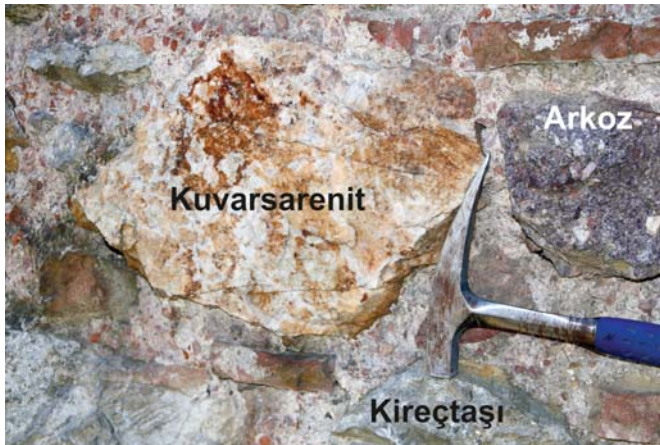
Şekil 6. Damatrix Sarayı'nın duvarlarında kullanılan arkoz (Kurtköy Formasyonu), kuvarsarenit (Aydos Formasyonu) ve kireçtaşları (Dolayoba ve Kartal Formasyonları)
