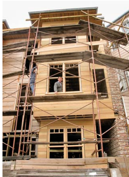
Resim 35. II.Dönem eki ahşap yapıda cephe uygulamasının aşamaları
