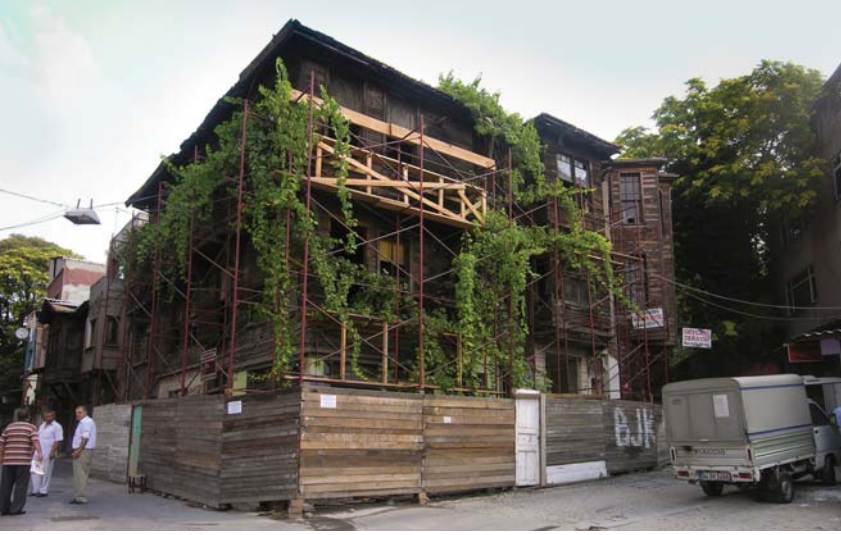
Resim 11. Ana yapı ile II.Dönem eki ahşap yapının 2008 yılındaki durumu
