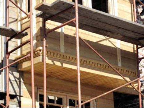
Resim 34. Kat silmelerinin uygulanması
