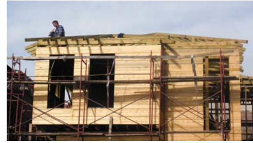
Resim 26. Çatı iskeletinin yapım aşamaları
