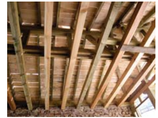
Resim 27. Kiremit altı kaplama tabakalarının uygulanması
