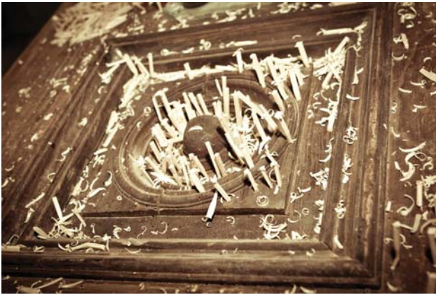
Resim 3. Uçuş deliklerinin kapatılması
