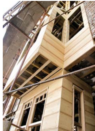
Resim 32. Cephe kaplama levhalarının montajı
