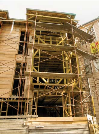
Resim 35. II.Dönem eki ahşap yapıda cephe uygulamasının aşamaları
