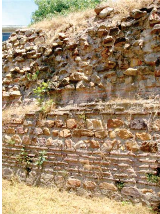
Şekil 3. Damatris Sarayı almışık duvar örgüsü örneği (Bölge 3). Duvarın alt kesiminde genellikle sert, dayanıklı kuvarsit kayaları kullanılmıştır. Katmanlar, 1-1,5m kalınlığında taş ve yaklaşık 1m kalınlığında tuğla dizilerinden oluşmaktadır.
