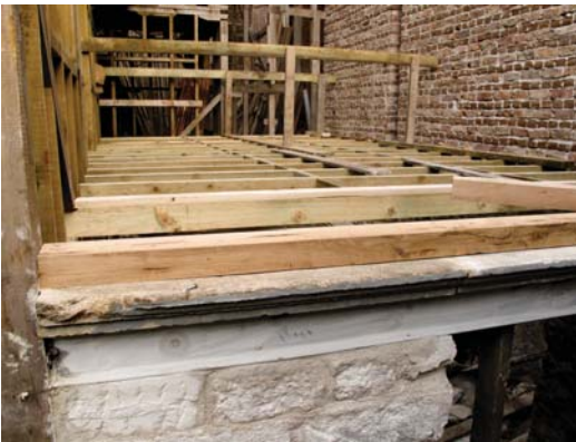
Resim 19. Karkas sistemin üzerine oturtulduğu meşe taban kirişi
