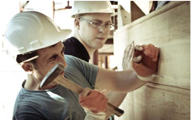
Resim 31. Cephe kaplama levhalarının hazırlanması
