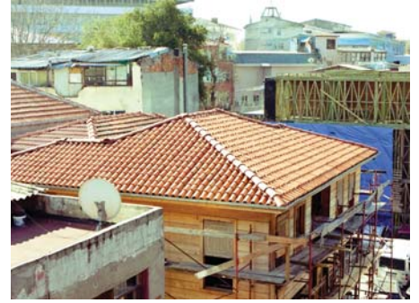
Resim 30. Çatının onarım sonrası durumu
