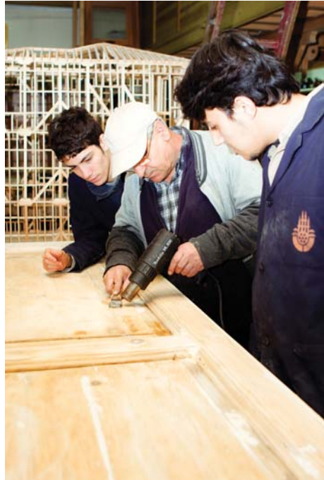
Resim 2. Ahşap yüzeylerindeki boya sökümü işlemleri
