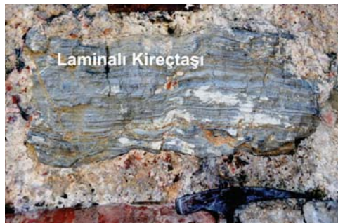
Şekil 8. Damatrix Sarayı'nın duvarlarında kullanılan laminalı kireçtaşı (İstinye Formasyonu)
