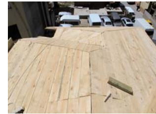
Resim 27. Kiremit altı kaplama tabakalarının uygulanması
