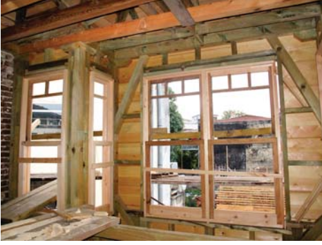
Resim 33. Pencere ve pervazların montajı
