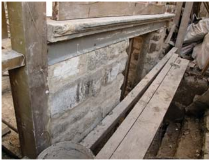
Resim 18. Kârgir bodrum kat duvarının uygulama öncesi ve sonrası
