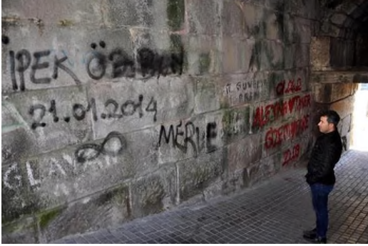
Şekil 7: Kale Duvarlarında Vandalizm ( http://arkeolojihaber.net/2015/12/ )
