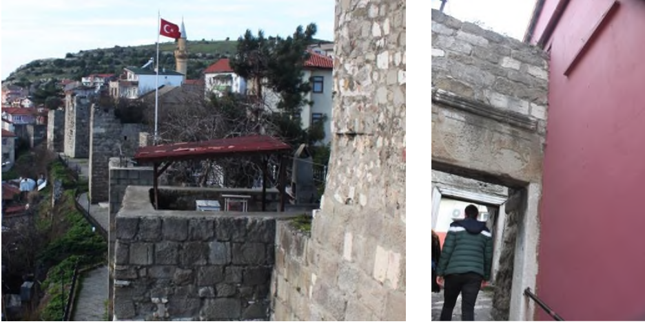
Şekil 5: Solda Kule Yapısının Şahsi Kullanımı, Sağda Betonarme Yapının Kaleye Bitişik Duvarı
