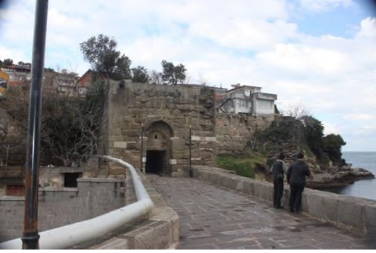
Şekil Hata! Belgede belirtilen stilde metne rastlanmadı. 6: Kemere Köprüsü'nün Günümüzdeki Görünümü
