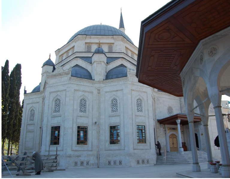
Şekil 20: Seyyid Nizam Câmii Batı Cephesi Görünümü.
