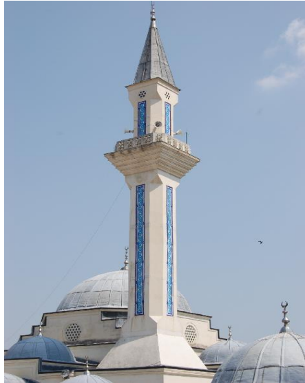
Şekil 12: Bahçeşehir Câmii Minaresi.
