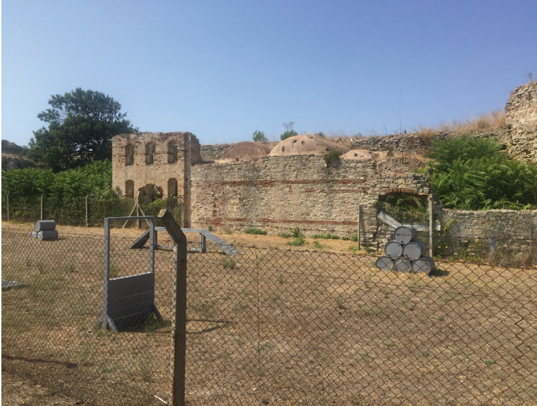
Fotoğraf 8- Kumkale Kalesi, güney surundaki hamam. (22 Ağustos 2019)
