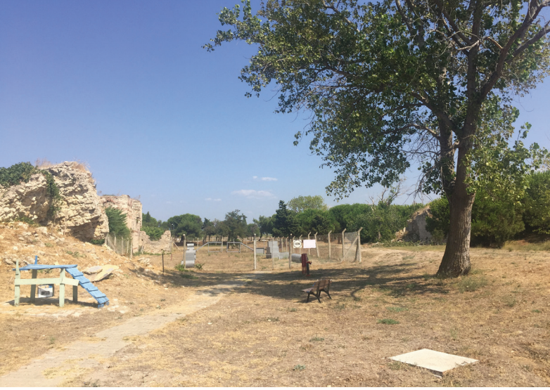
Fotoğraf 7- Kumkale Kalesi, su deposu ve kavak ağacı yönünden kule ve hamamlar yönüne bakış. (22 Ağustos 2019)
