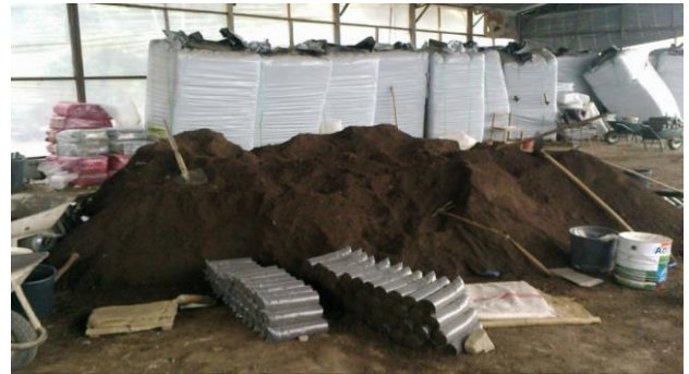
Şekil 2. Hazırlanan harç malzemesi (Foto: A. ÜNAL)
