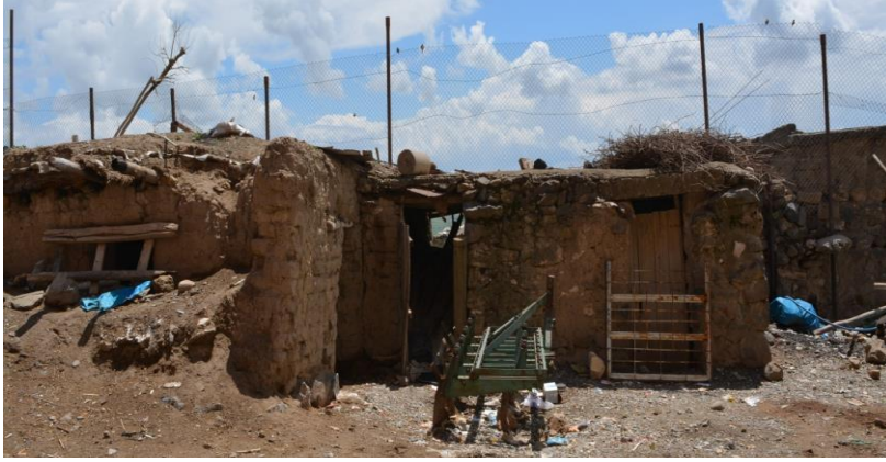
Resim 23 – Kuzey Cephesi Görünümü
