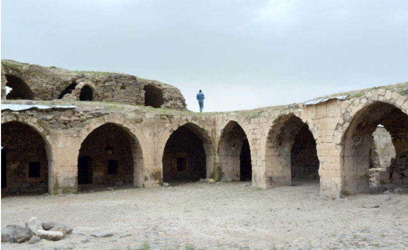
Resim 11 - Güney-Batı Revaklı Bölüm görünümü
