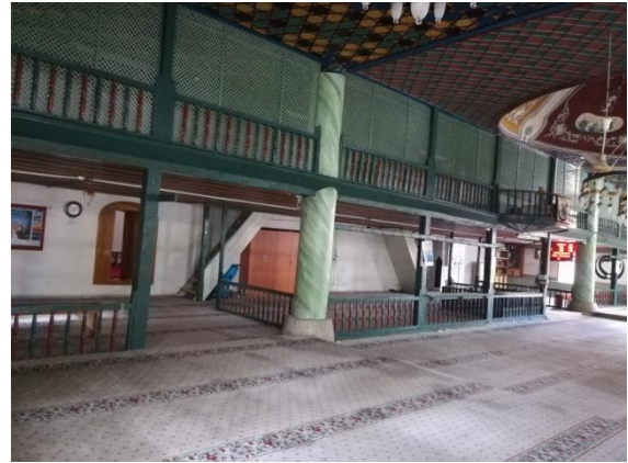
Resim 10: Koca Seyfullah Cami, Kuzey duvar genel görünüm.
