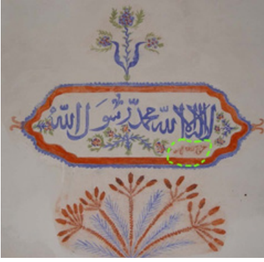
Şekil 25: Güney Duvarı Sıva Üstü Kalem İşleri (2012 restorasyonu Öncesi)
