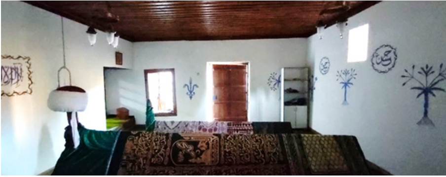
Şekil 41: Türbe Sıva Üstü Kalem İşleri (2012 Restorasyonu Sonrası)
