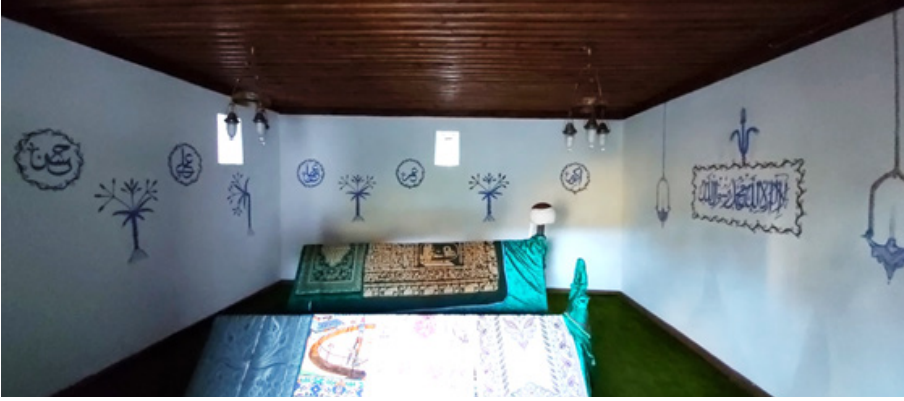
Şekil 40: Türbe Sıva Üstü Kalem İşleri (2012 restorasyonu Sonrası)
