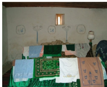
Şekil 36: Türbe Sıva Üstü Kalem İşleri (2012 restorasyonu öncesi) (Kaynak: K.V.B.M. Arşivi)
