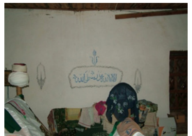
Şekil 37: Türbe Sıva Üstü Kalem İşleri (2012 restorasyonu öncesi) (Kaynak: K.V.B.M. Arşivi)
