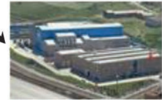
İzinli Alıcının Tesisi
