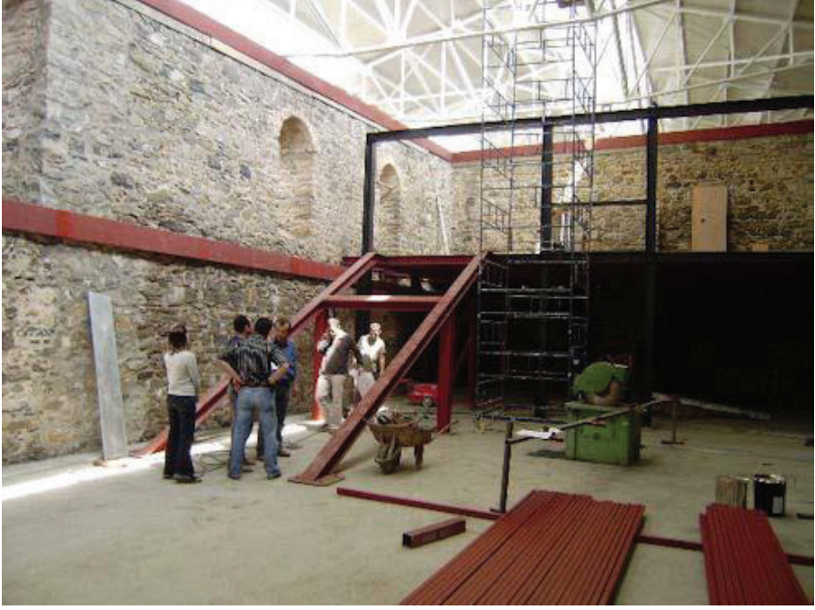
Şekil 3. Tuz Ambarı restorasyonu sırasında elik strüktürlerin kurulumu [8].
