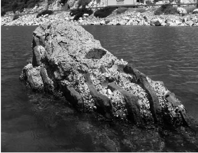
Res. 10b Hamam duvarının su üstünde kalmış bölümü
