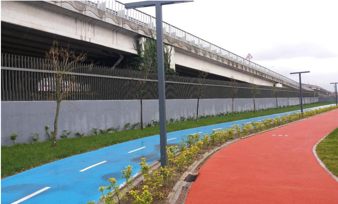
Şekil 7. Kot Farkına Karşı Yapılan İhata Duvarı
