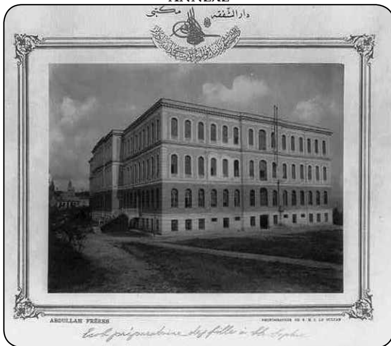
Photo 1. Bâtiment de Darüşşafaka prise pendant la période ottomane https://www.degisti.com/index.php/archives/18475 (Date d'accès: 03.02.2020)
