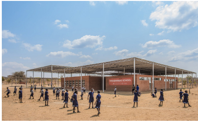
Görsel 1. Çocukların görme duygusunu destekleyen yapı ölçeği, Glyfada Anaokulu, Yunanistan (Üstte) Mwabwindo Okulu, Zambiya (Altta)
