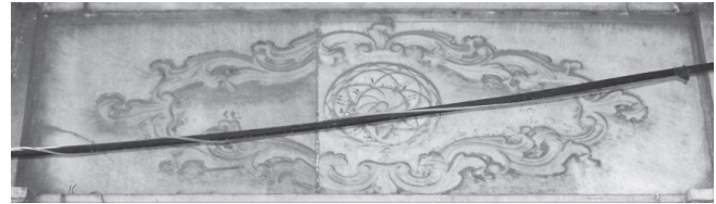
Resim 12 : Beden Duvarlarının üst Bölümünde yer alan Panolar
