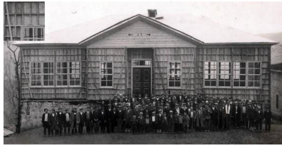
Fotoğraf 17: Keşap Barça Köyü’nde İlköğretim Okulu İnşaatı – 1930’lu yıllar (İltar, tezinden fotoğraflar c)
