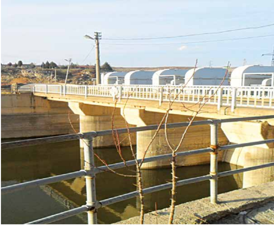
Şekil 3.5. Enne Baraj Gölünde bulunan savaklar
