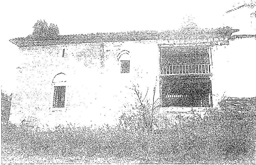
Res.4- Eski Furunlu Köyü Hacı İbrahim Camii. Doğu cephesi.
