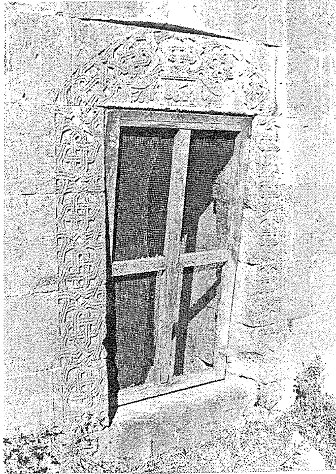
Res.5- Nuhiye Türbesi. Güney pencere.
