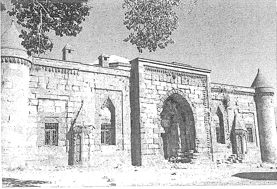
Res.1- İhlasiye Medresesi. Giriş Cephesi.
