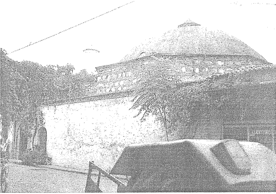
Res.15- Yeni (Gülruh Sultan) Hamam. Güneyden görünüş.
