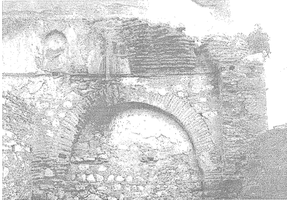
Res.6- Sasa Bey (Şehir) Hamamı. Kadınlar bölümü soyunmalık mekanı.
