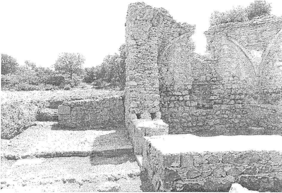
Res.12- Zaviye. Konservasyon işlemleri sonrası yapının kuzeydoğudan görünüşü.
