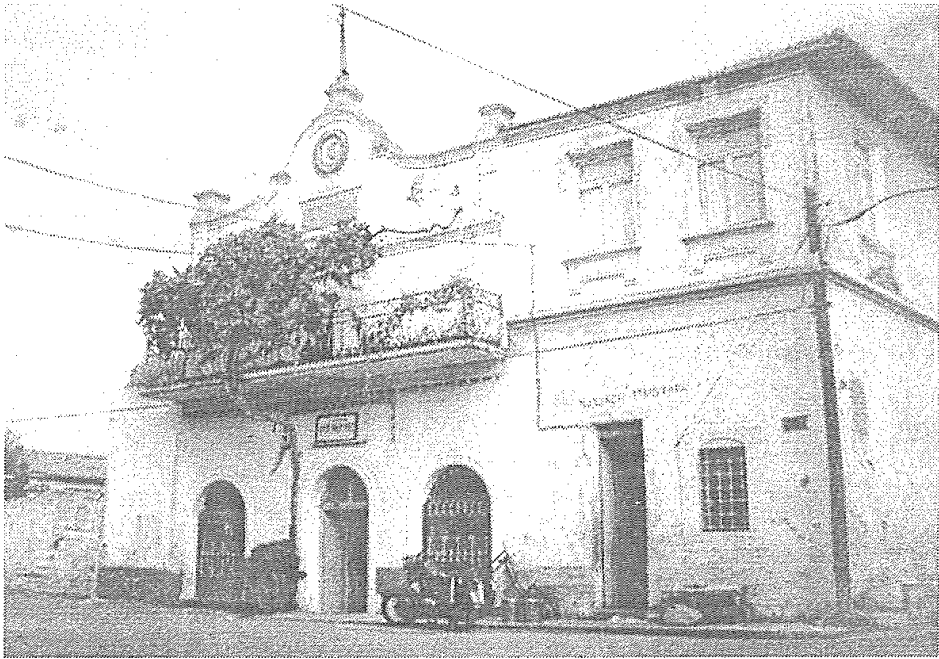
Res.2- Sasa Bey (Şehir) Hamamı. Güney cephesi.
