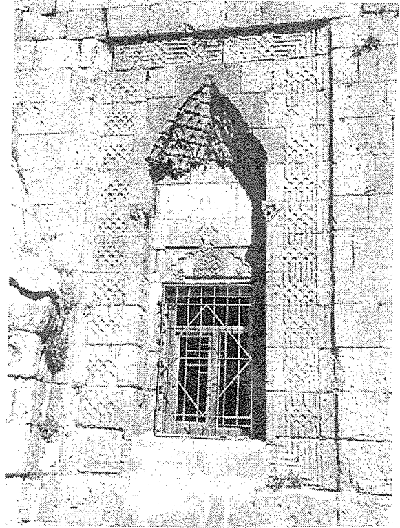
Res.4- İhlasiye Medresesi. Güney cephede yer alan pencerelerden biri.
