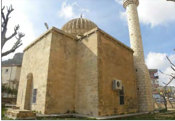
Foto. 10 Hamza-i Kebir Camii Güneydoğu köşeden görünüşü
