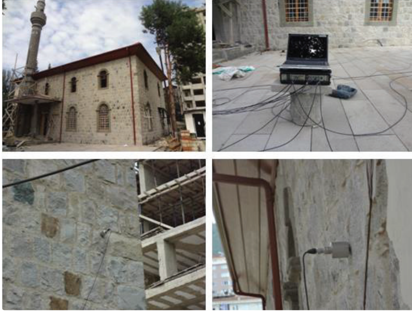
Şekil 13. Büyük Gülbahar Camisindeki restorasyon sonrası ölçümde ivmeölçer yerleşimleri ve veri toplama sistemine ait görüntüler
