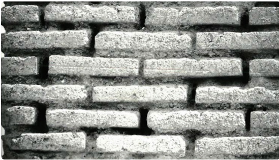
Resim 46- Mursaman Türbesi güney cephenin batısı
