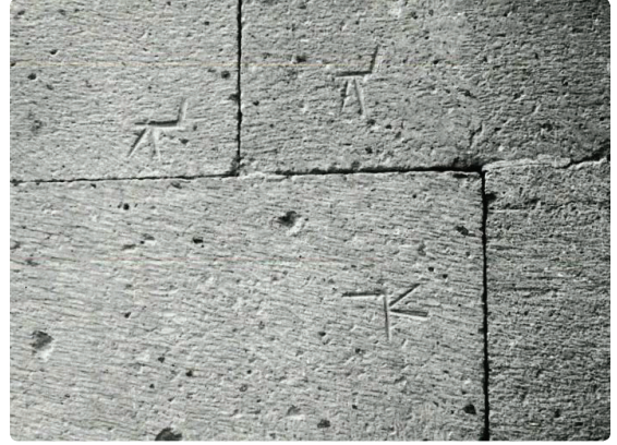
Resim 34- Gömeç Hatun Türbesi güney cephe ayrıntı
