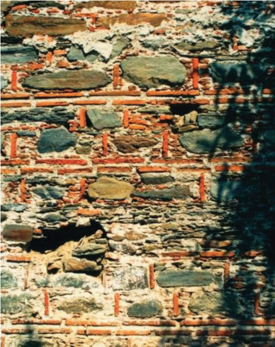
Resim 6. Tire Duatepe Mahallesi İsimsiz Türbe duvar detayı (dıştan).
