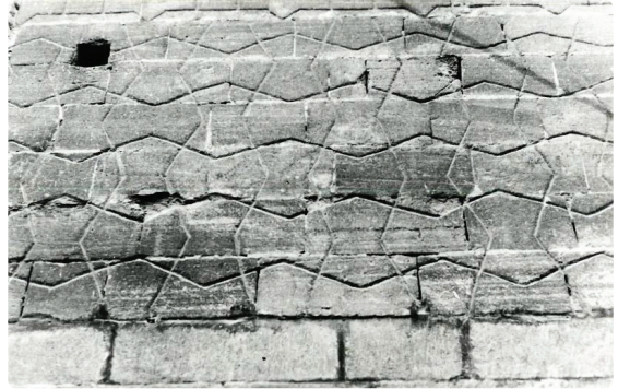
Resim 33- Seyfeddin Sungur Türbesi batı cephe ayrıntı
