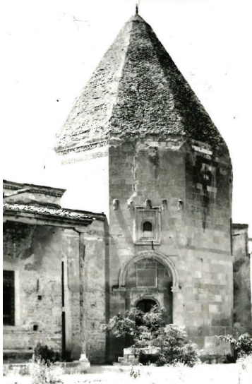
Resim 1- II. Kılıçarslan Türbesi kuzeydoğu cephe
