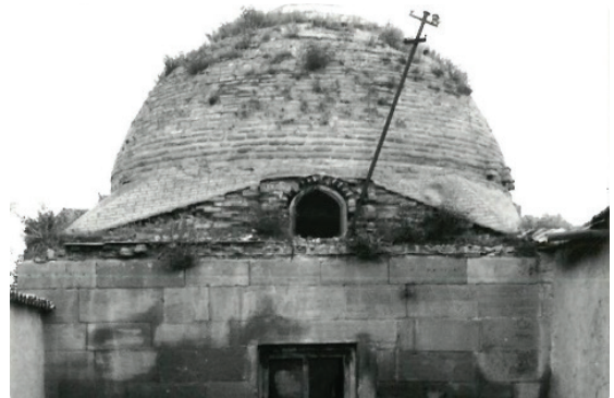
Resim 5- Halka Begüş Mescidi batı cephe
