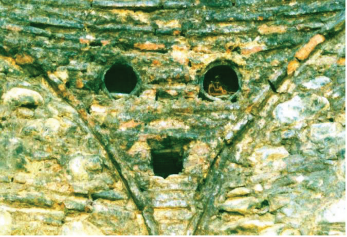
Resim 11. Tire Duatepe Mahallesi İsimsiz Türbe Kubbe geçişleri detayı.
