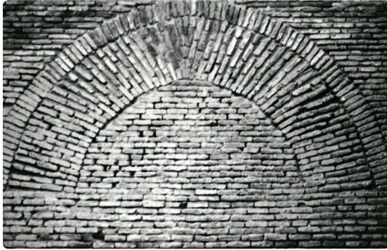
Resim 37- İplikçi Camii güney cephe, mihrabın arkasındaki kemer
