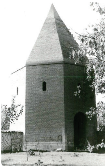
Resim 11-- Ulaş Baba Türbesi kuzeydoğu cephe
