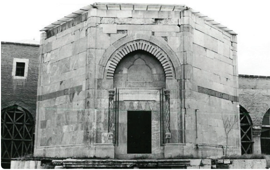
Resim 8- Anonim Türbe kuzey, kuzeydoğu kuzeybatı cepheler
