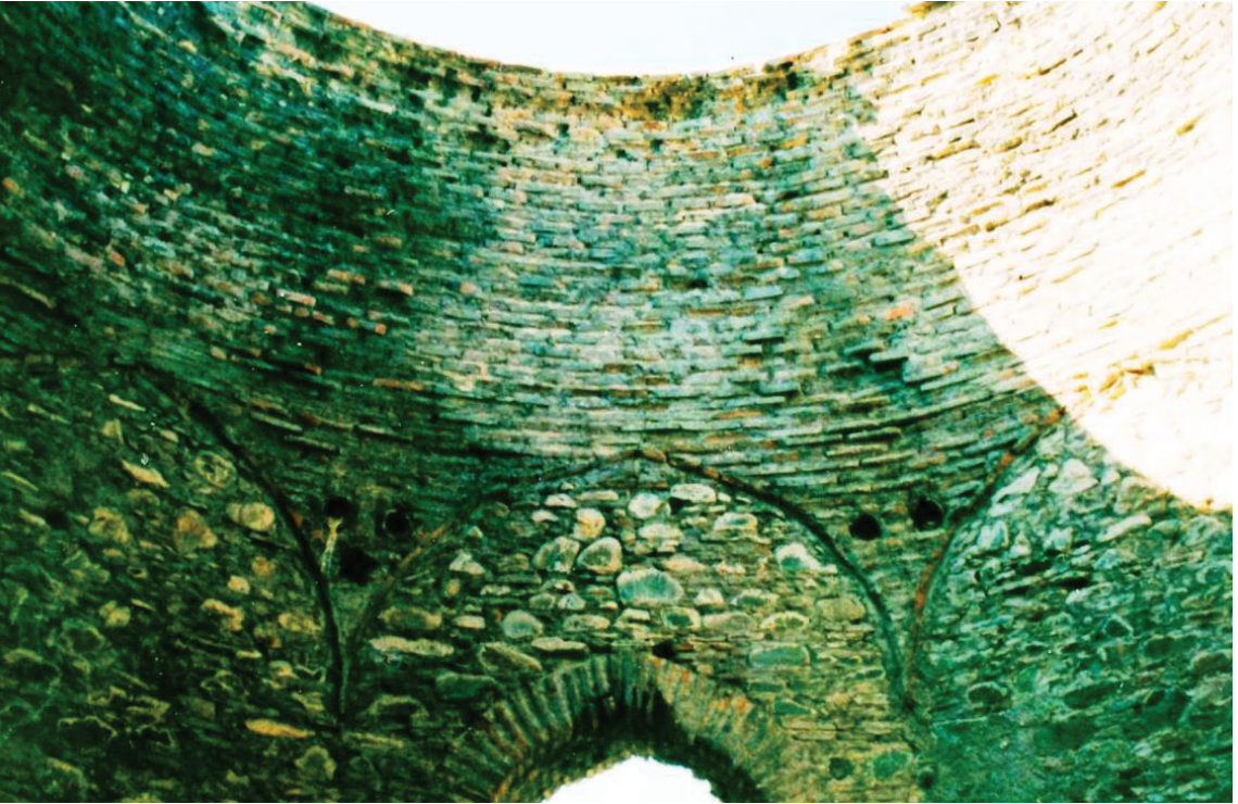
Resim 10. Tire Duatepe Mahallesi İsimsiz Türbe içten kapı üstü kubbeye geçiş ve kubbe.
