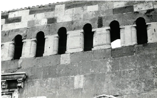
Resim 27- Alaeddin Camii kuzey cephe, doğu bölüm galeri, ayrıntı
