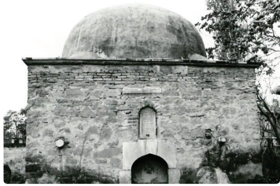
Resim 14- Şeyh Alaman Türbesi kuzey cephe
