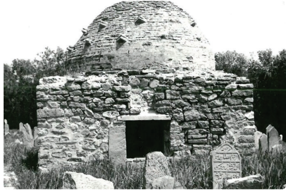
Resim 13- Evhadeddin-i Kirmani Türbesi batı cephe
