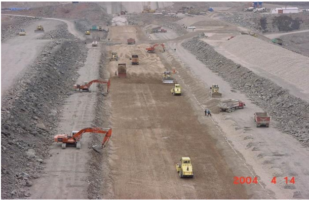
Şekil 5. Çekirdek Kilinin Dökülmesi ve Sıkıştırılması
