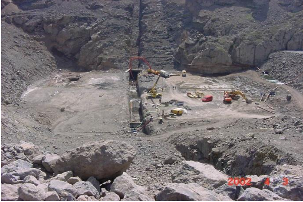
Şekil 4. Enjeksiyon Perdesi Oluşturma Aşaması
