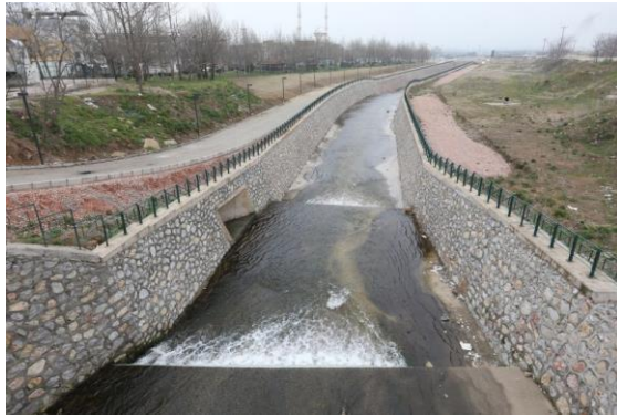
Şekil 2. Taşkın Kontrol Kıyı duvarı
