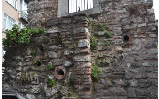
Şekil 7. Valens (Bozdoğan) Kemer ve su taşıyan künkler (2015).
