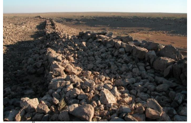
Şekil 1. Ürdün'de kalıntıları bulunan Jawa Barajı [5].
