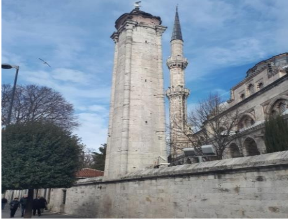
Şekil 12. Şehzadebaşı Camii avlusunda bulunan su terazisi (2020).
