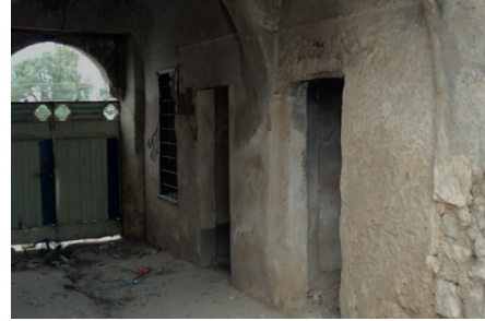
Görsel 13: Kuzey batı cephesindeki odalar.
