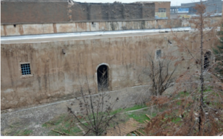
Görsel 22: Kışlanın batı cephe odaları.
