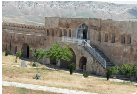
Görsel 27: Koysancak Kışlasının doğu cephesinin içgörünüümü.
