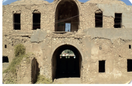
Görsel 11: Güver Kışlasının kuzey cephesinin görünümü.
