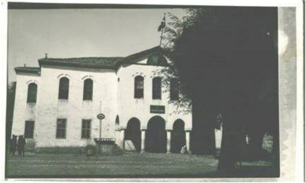
Figür 3: Bozkır Hükümet Konağı'nın ön cephesi ( www.bozkir.net )
