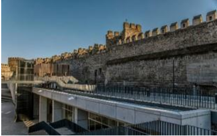
Şekil 10. Kültür Merkezi İnşası 14
