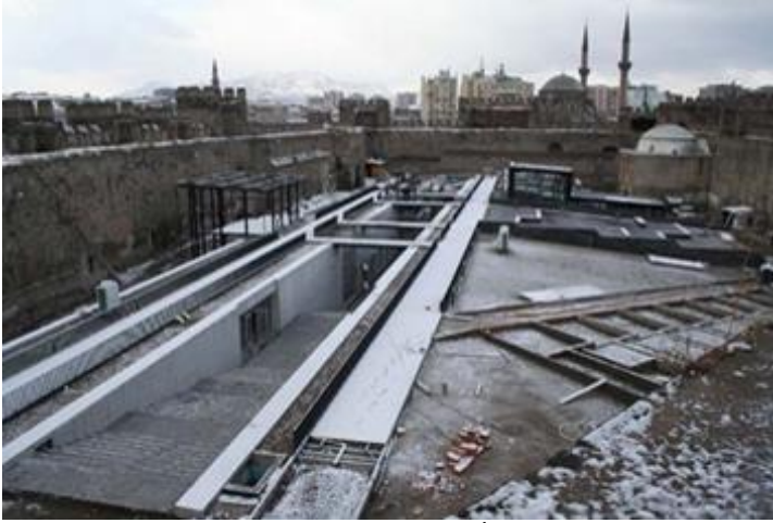
Şekil 9. Kültür Merkezi İnşası 13
