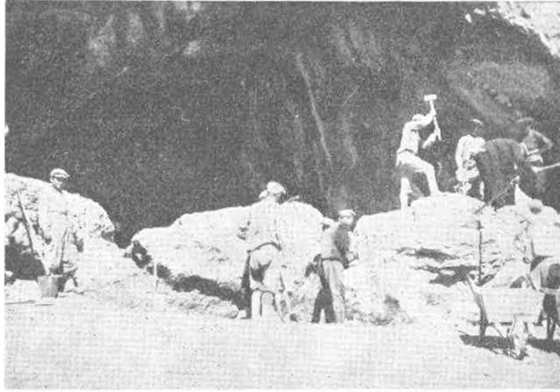
Res. 2 — Mağara önündeki uçuk, atık taş bloklarının kaldırılması ve ön seki kazısına hazırlık.
