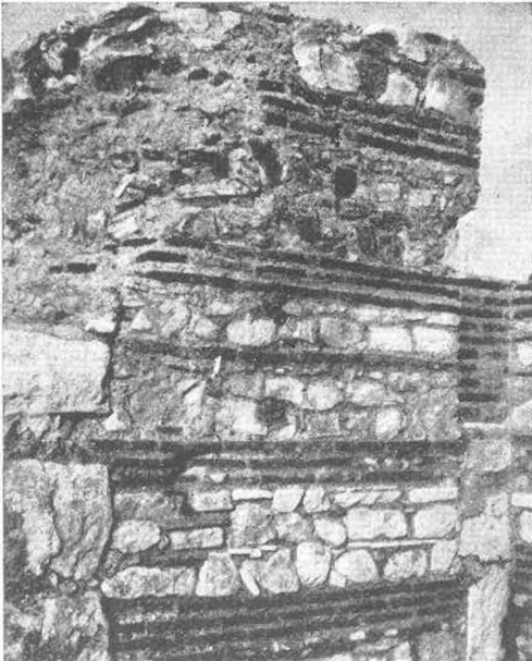
Res. 3—Tuğla hatıllı duvarlardan bir örnek.
