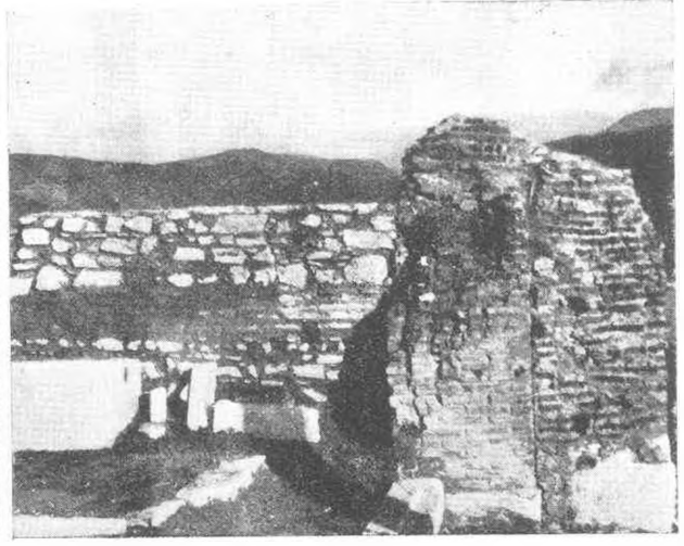
Res. 6—Apsisin hemen kuzey bitişiğinde ana duvara desteklik eden (gerideki) tuğla hatlı kütle duvar.
