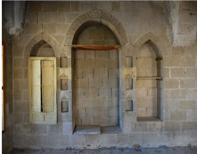
Resim 18: Süphi Yertüm Evi Başoda Duvar Nişleri (Karabulut,2019)
