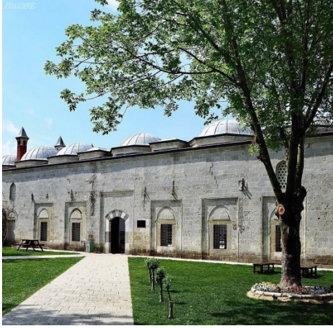
Resim 6. Darüşşifa Dış Cephe
