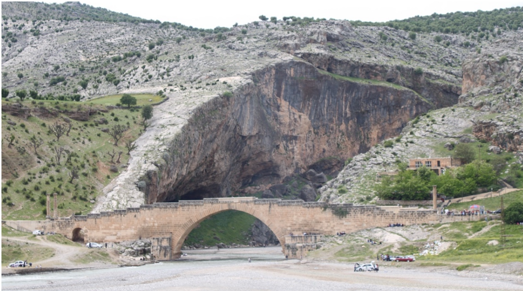
Resim 3. Cendere (Septimius Severus) Köprüsü (Kaya Derinoğullu 2015)
