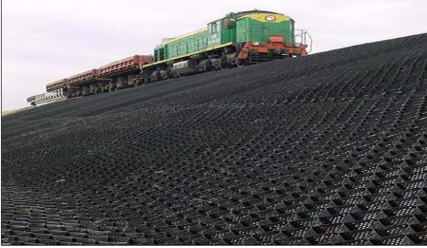
Şekil 2. Demiryollarında Geocell kullanımı (Tarsu, 2021)
