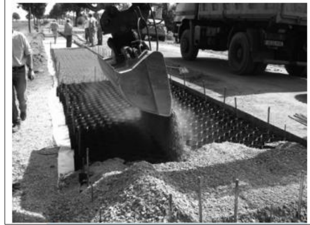
Şekil 3. Asfaltsız yollarda Geocell takviyesinin uygulanması (Emersleben vd., 2008)
