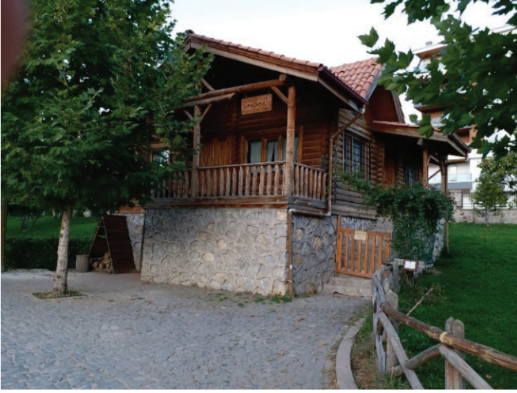
Şekil 13. İnşa edilen ofis yapısı (Seda Öztekin Mayıs,2019).
