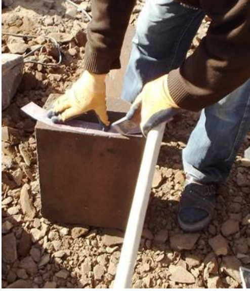
Resim 5. Kalıpla Ölçü Alımı
